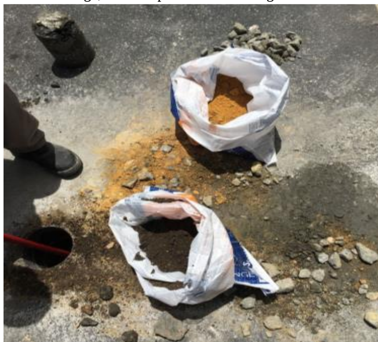
Figura 75 - Material granular das camadas de base e sub-base do revestimento asfáltico da avenida Caxangá, extraído por meio de sondagem a trado.
