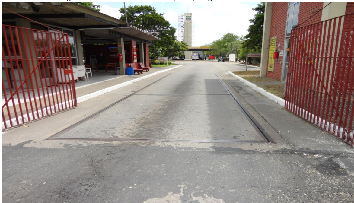
Figura 58 - Plataforma da balança de pesagem de eixos de veículos.
