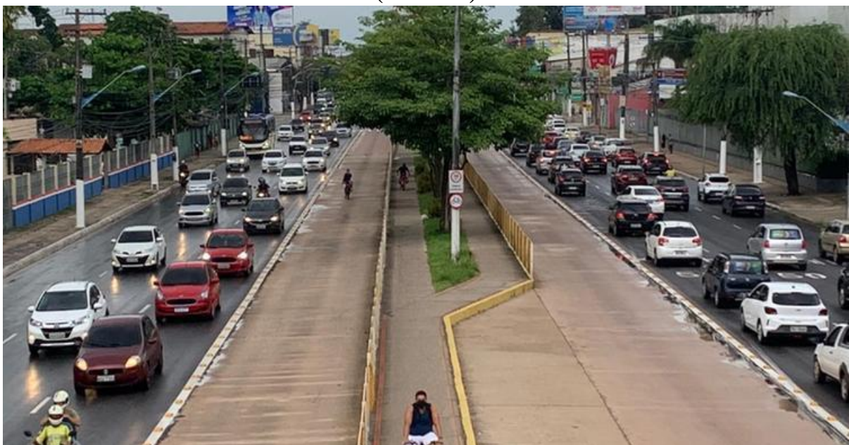
Figura 29 - Vista geral do corredor de BRT implantado ao longo da avenida Almirante Barroso (Belém/PA).
