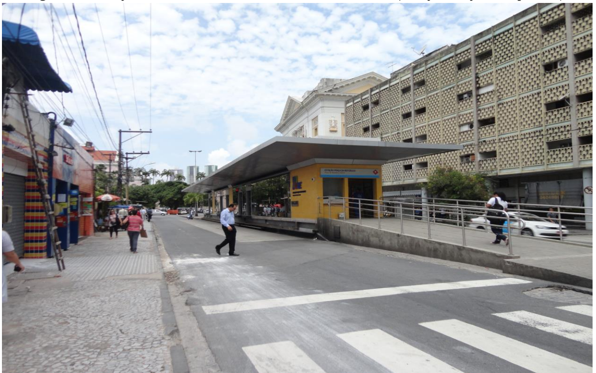
Figura 25 - Estação de BRT na área central da cidade do Recife (Estação Praça da República).
