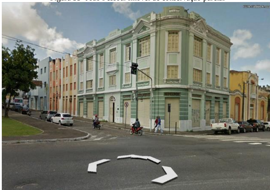
Figura 35- João Pessoa. Imóvel de conservação parcial
