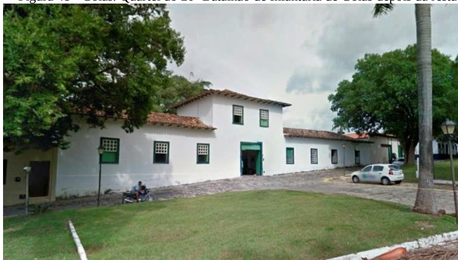
Figura 48 - Goiás. Quartel do 20 o Batalhão de Infantaria de Goiás depois da restauração.
