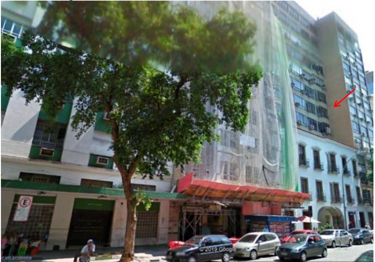
Figura 26 - Rio de Janeiro. Prédio construído sobre o edifício Arco do Teles
