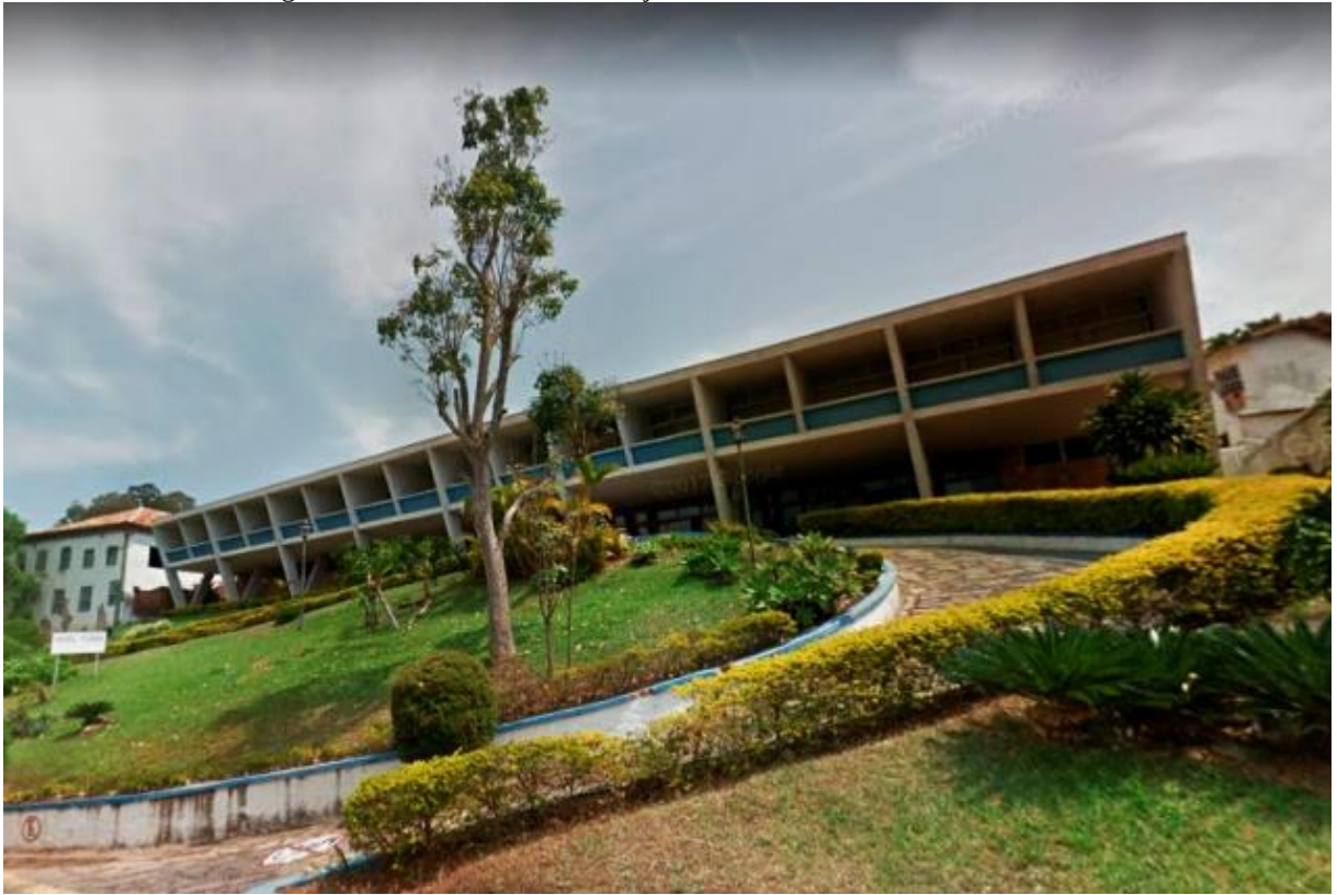
Figura 16 - Diamantina. Hotel Tijuco ao nível da Rua Macau do Meio
