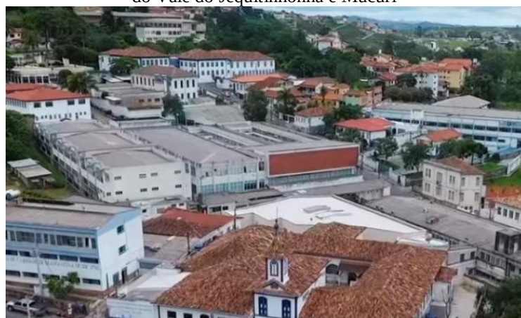
Figura 23 - Diamantina. Vista atual do conjunto da atual Universidade Federal do Vale do Jequitinhonha e Mucuri
