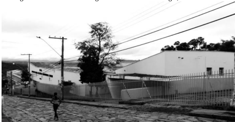
Figura 22 - Diamantina. Antiga Faculdade de Odontologia, vista do edifício
