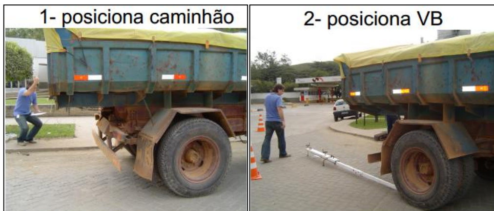
Figura 3 – Esquema Operacional da Viga Benkelman (Posicionamento do caminhão e da Viga)
