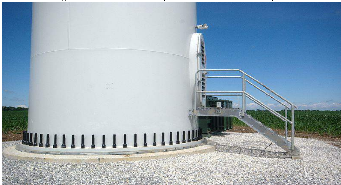
Figura 7 - Vista de uma seção da torre e abertura da porta
