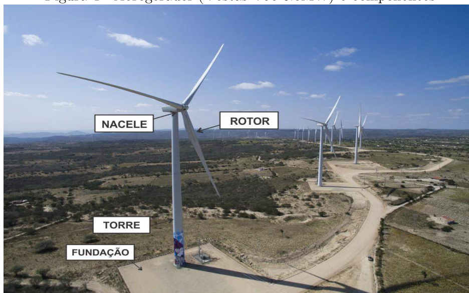
Figura 4 - Aerogerador (Vestas V90-3.0MW) e componentes
