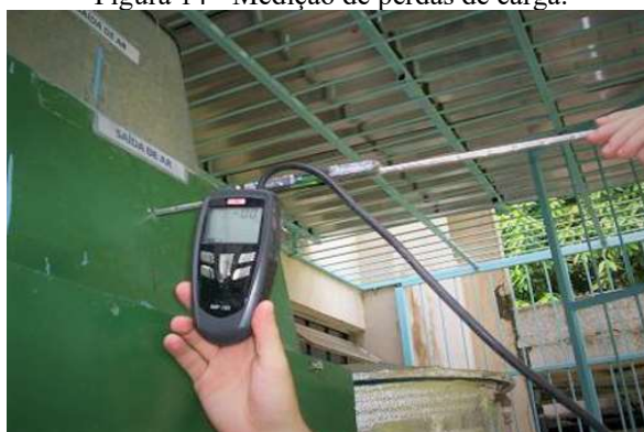
Figura 14 - Medição de perdas de carga.
