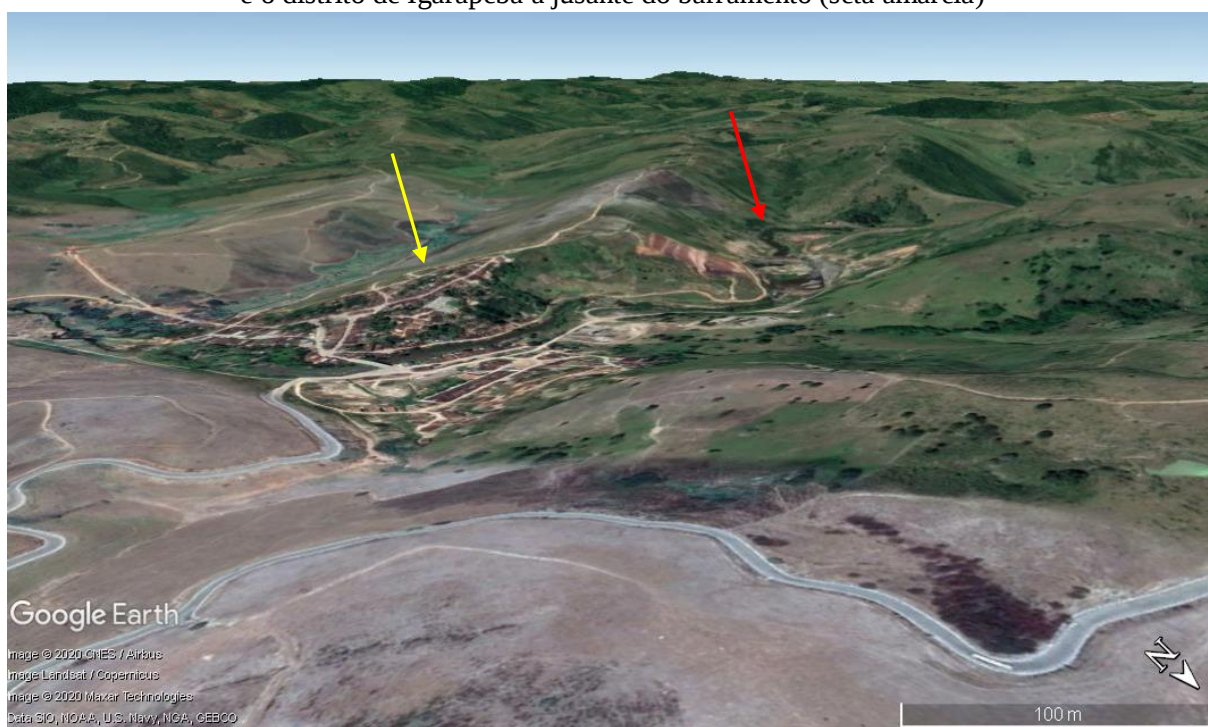
Figura 26 – Visão ortogonal demonstrando o relevo da área da barragem de Igarapeba (seta vermelha) e o distrito de Igarapeba a jusante do barramento (seta amarela)
