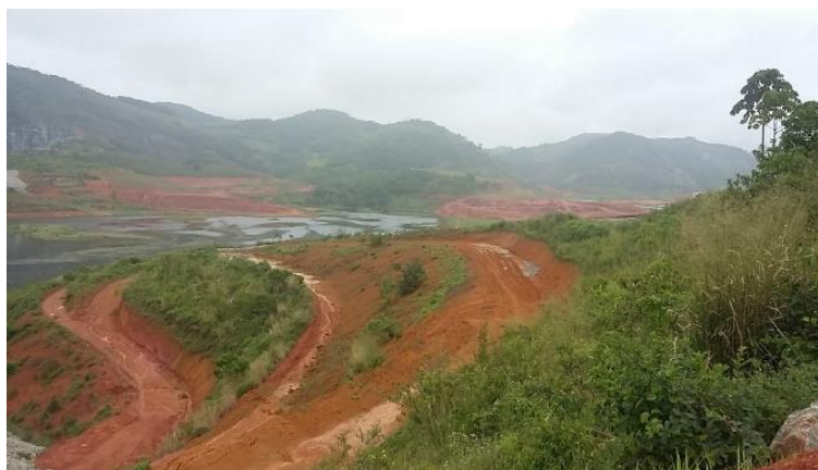
Figura 33 – Panorama das alterações na morfologia da área da barragem Serro Azul decorrentes da etapa de construção
