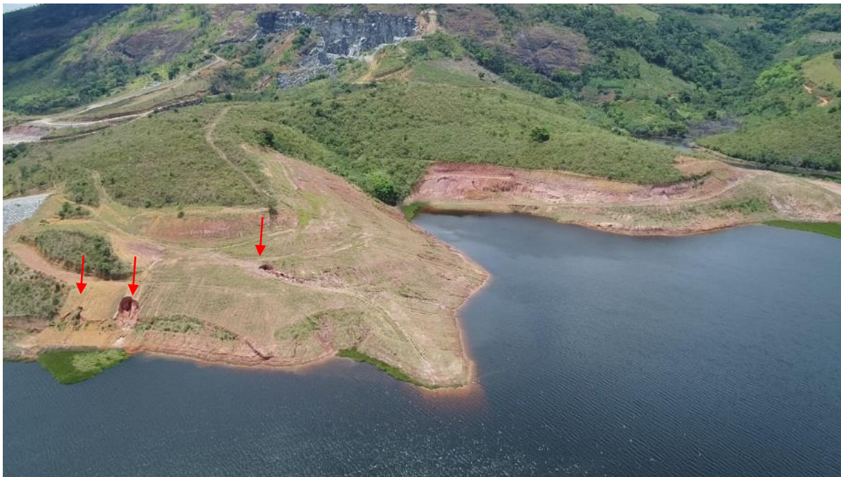
Figura 42 – Uma visão geral da margem direita do reservatório demonstra a existência de diversas áreas com solo exposto, sendo um facilitador para a ocorrência dos processos erosivos
