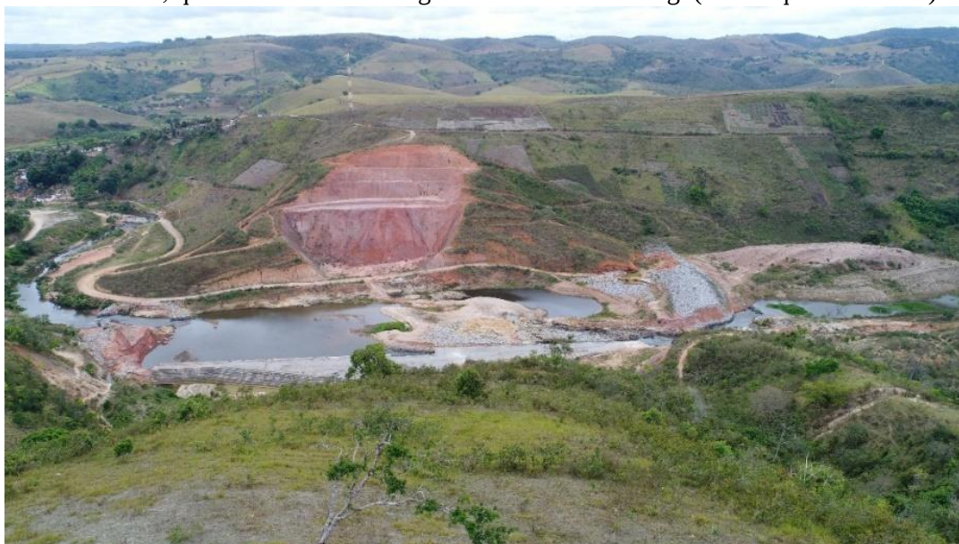
Figura 18 – Visão ampliada do trecho do futuro barramento da barragem de Igarapeba a montante da comunidade, que se encontra na margem direita do rio Pirangi (lado esquerdo da foto)
