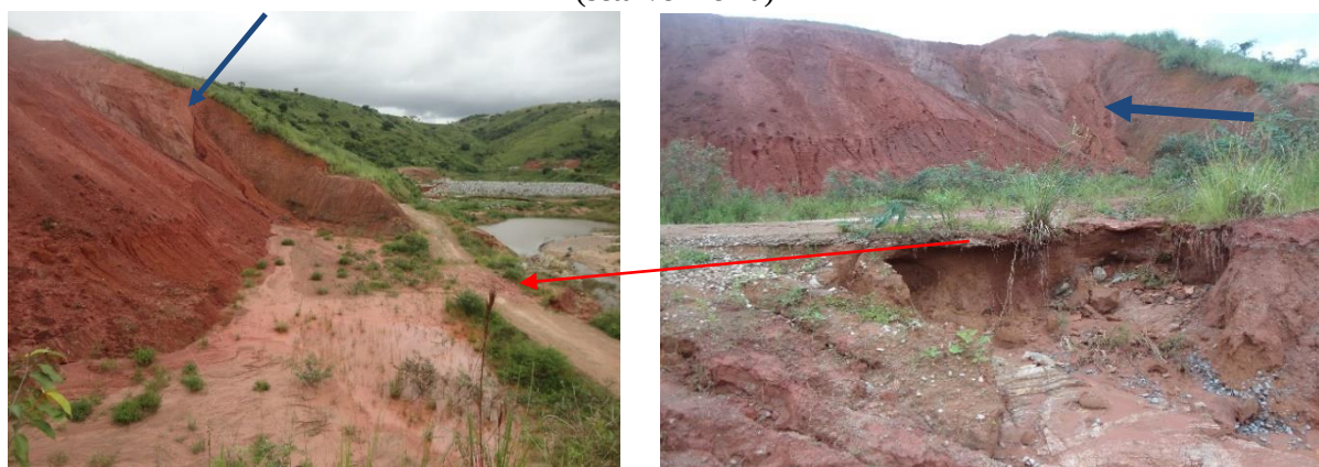
Figura 23 – Ombreira direita com o manto de intemperismo exposto (setas azuis), sendo afetado por processo erosivo, resultando em alcovas de regressão e deposição de sedimentos no leito do rio Pirangi (seta vermelha)
