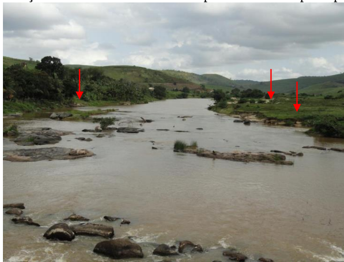
Figura 36 – Terraço fluvial do Rio Una em área próxima ao eixo principal da barragem
