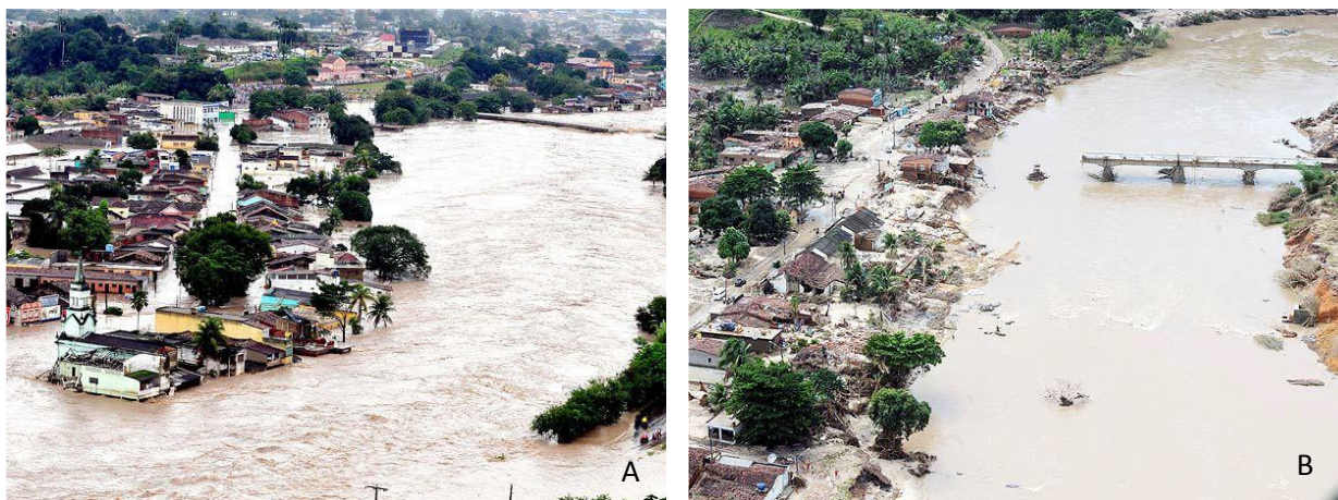
Figura 34 – As águas do Rio Una invadindo a cidade de Palmares – junho/2010 (a) e queda de parte da ponte sobre o rio Una, na cidade de Barreiros – junho/2010 (b)
