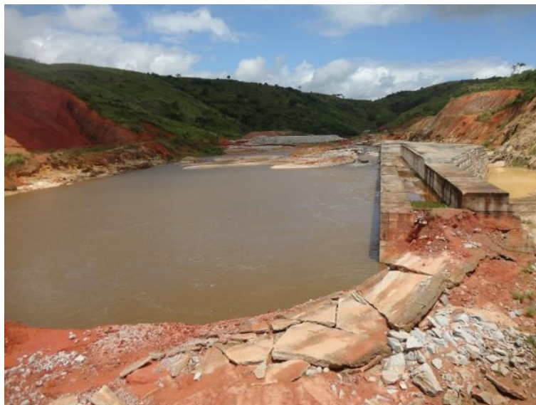
Figura 13 – Situação do estágio das obras da barragem de Igarapeba em 24 de agosto de 2017 e o fluxo do rio Pirangi
