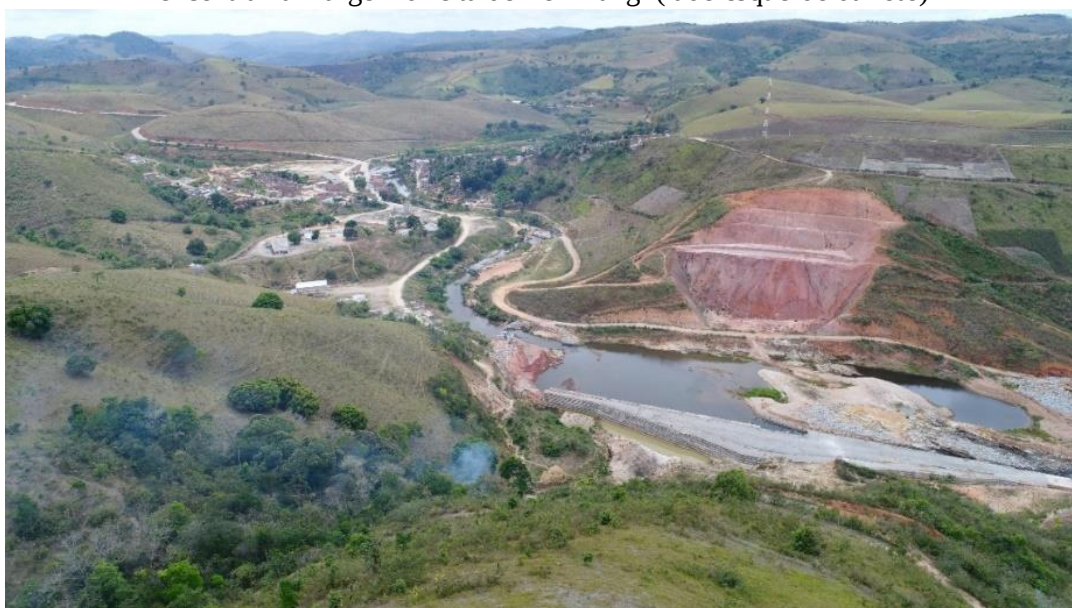
Figura 19 – Trecho do futuro barramento da barragem de Igarapeba a montante da comunidade, que se encontra na margem direita do rio Pirangi (lado esquerdo da foto)
