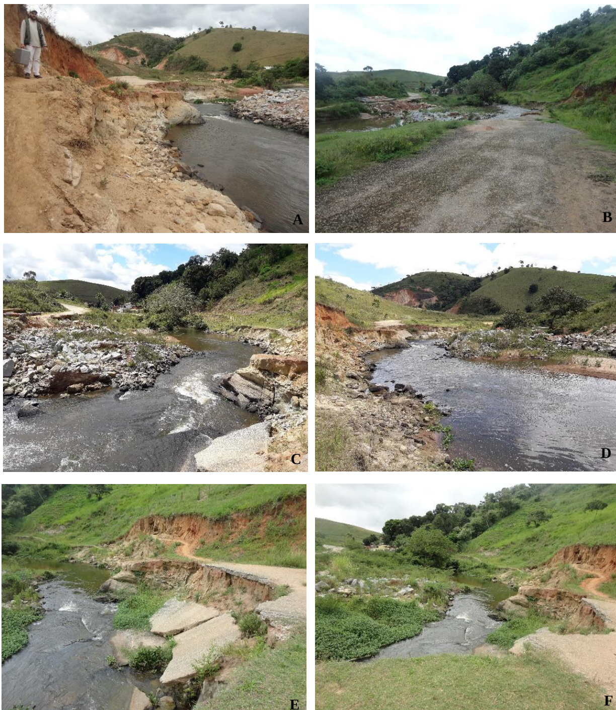
Figura 25 – Registro temporal (dezembro/2017 a abril/2019) na mesma área, a jusante do futuro barramento e a montante das moradias, com destaque para o asfalto utilizado pela obra da barragem
