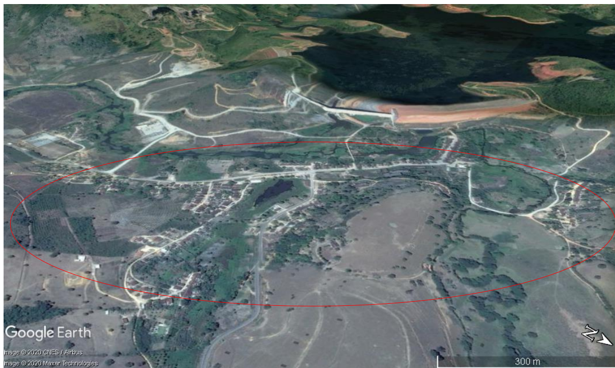
Figura 62 – Visão ortogonal demonstrando o relevo da área da barragem Serro Azul e o distrito de Serro Azul (destacado em vermelho) a jusante do barramento
