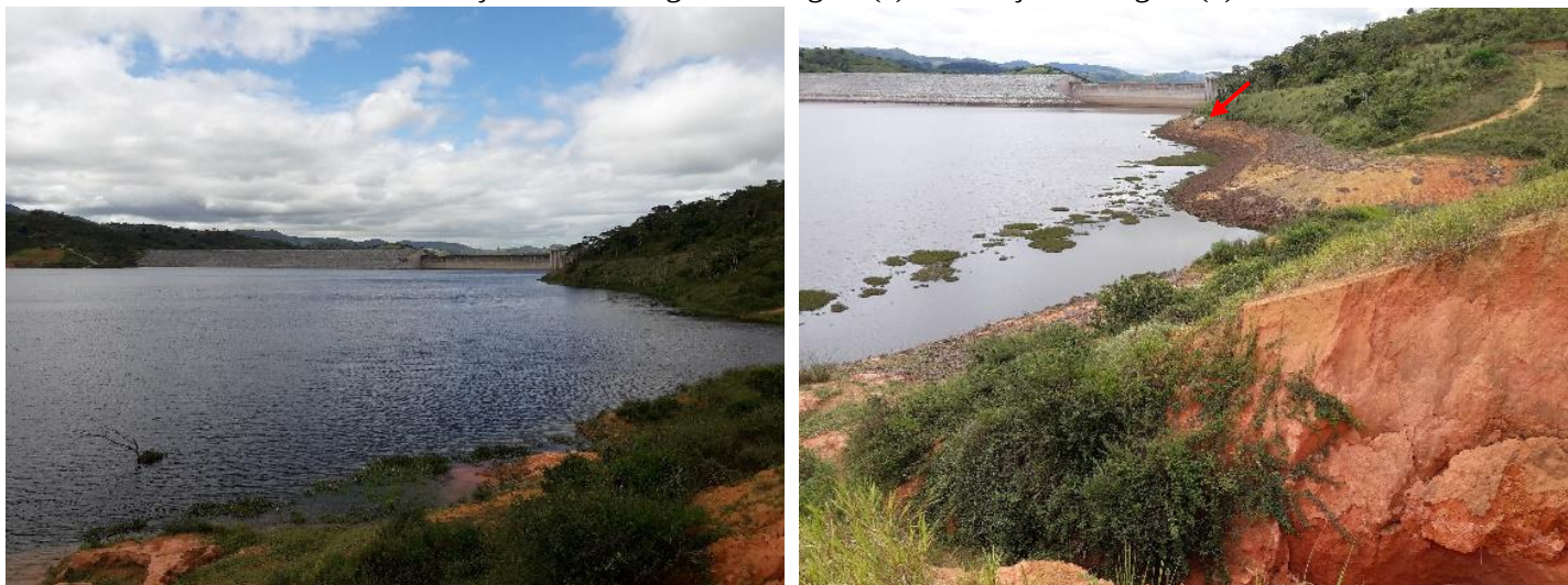
Figura 44 – Imagens retratam a área junto ao paredão da barragem, sendo evidenciada a diferença no nível d'água na imagem (a) em relação à imagem (b)
