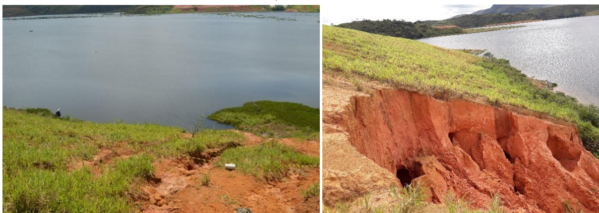
Figura 57 – Estaqueamento da voçoroca 1 na margem direita do reservatório da barragem Serro Azul, Palmares-PE
