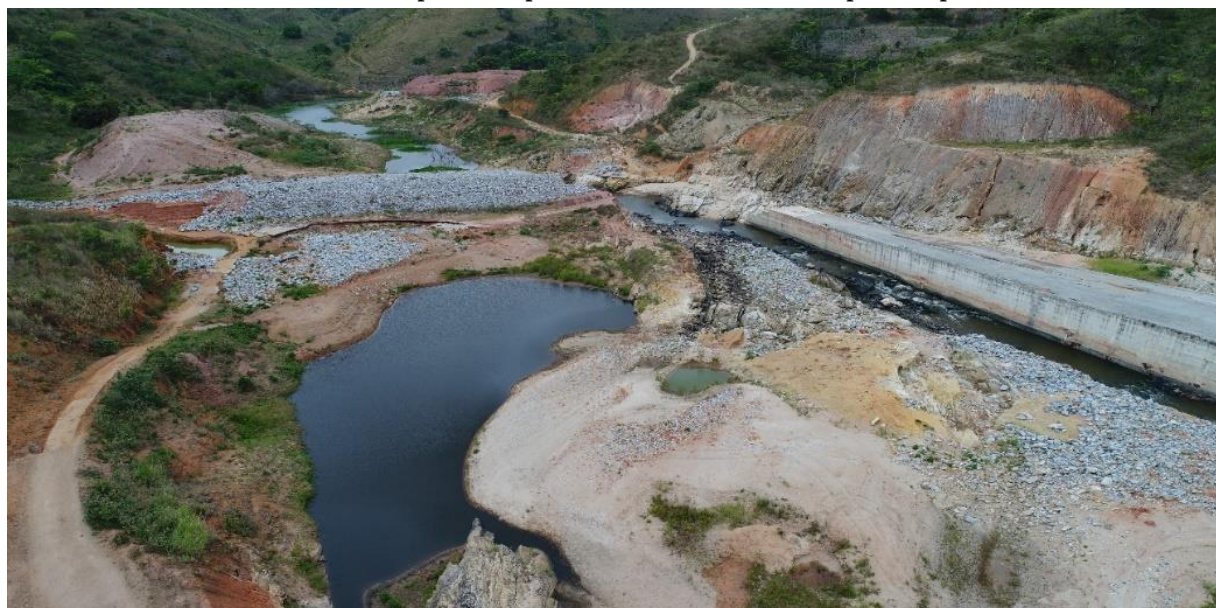
Figura 14 – Situação do estágio das obras da barragem de Igarapeba em 22 de dezembro de 2017, com a área do barramento no primeiro plano e área a montante na parte superior da foto
