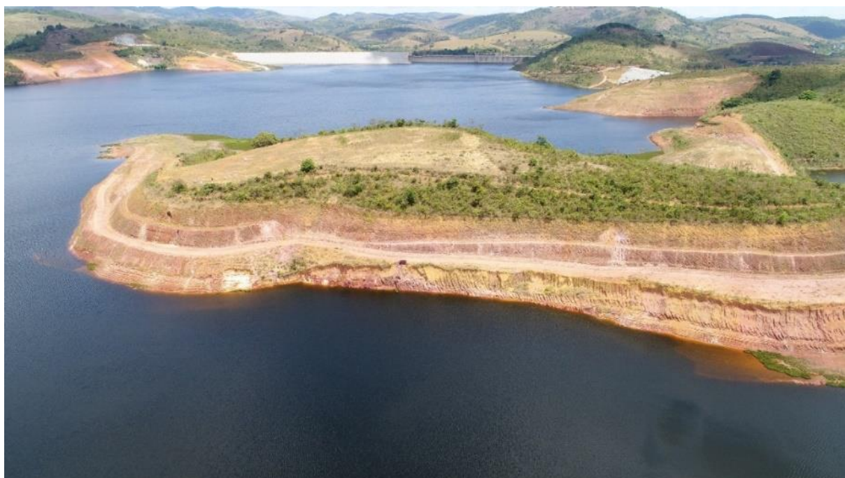
Figura 41 – Uma visão geral (com a barragem ao fundo) demonstra a existência de diversas áreas com solo exposto, sendo um facilitador para a ocorrência dos processos erosivos
