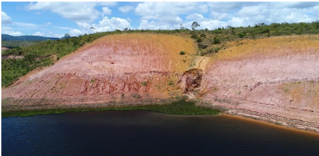
Figura 40 – Evidências de ravinamentos e um escorregamento na encosta localizada na margem esquerda do reservatório próximo ao barramento
