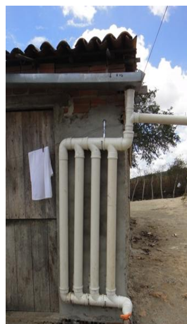
(d) Dispositivo concluído em LC4.
