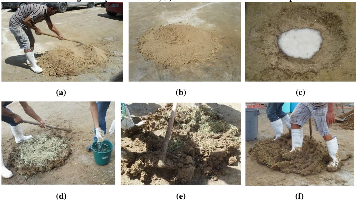
Figura 12 – Processo de preparação da mistura: (a) Homogeneização dos 5 baldes de terra; (b) Preparação da terra; (c) Adição da cola branca dissolvida em água; (d) Adição do feno; (e) Homogeneização da mistura; (f) Amassamento do barro com os pés.
