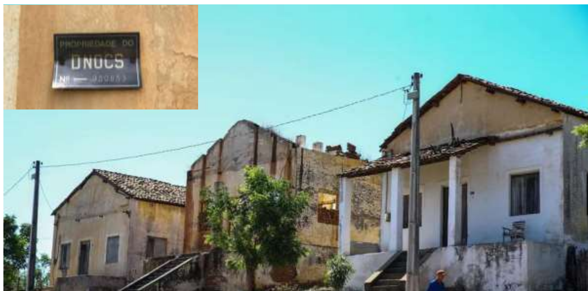
Ruínas do espaço de confinamento na localidade do Sítio do Patu, Senador Pompeu -CE. Foto extra da placa de registro patrimonial do DNOCS.
