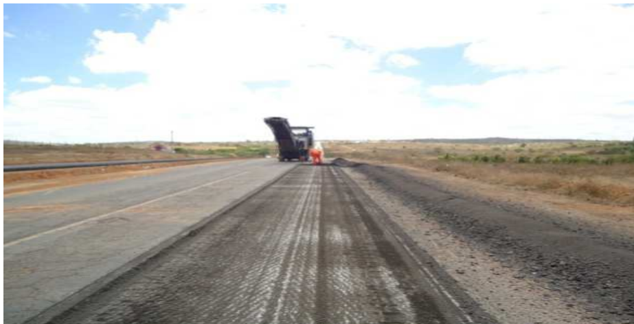
Figura 2.4 – Procedimento de fresagem a frio de pavimento da BR-104/PE
