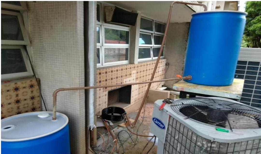
Figura 20 - Construção do sistema hidráulico e refrigerante
