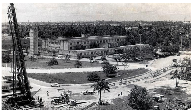
Figura 2.1 – Construção da UFPE
