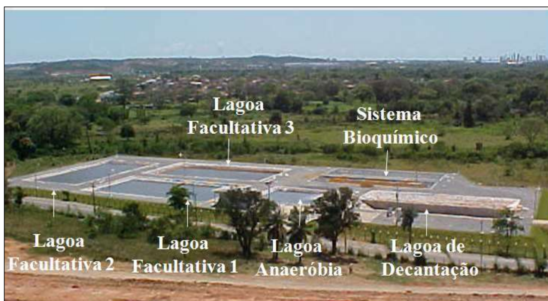
Figura 11 – Estação de Tratamento de Lixiviados do Aterro da Muribeca
