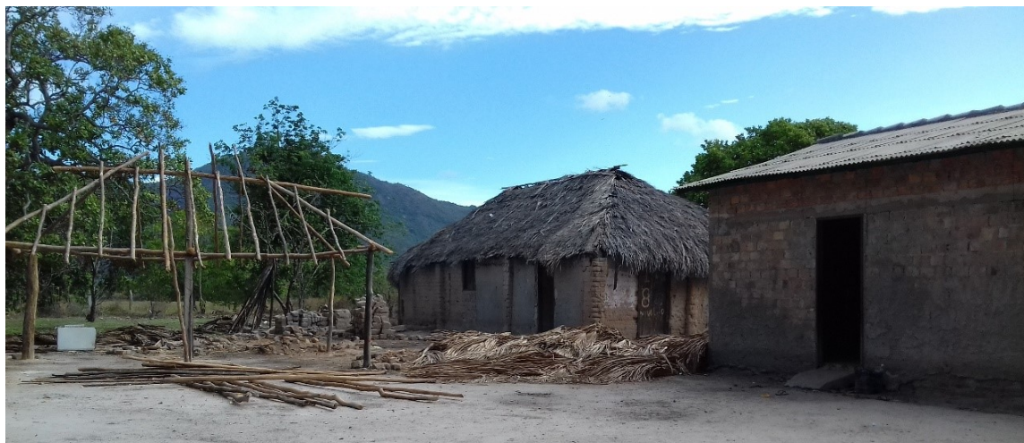
Foto 26: Casas: em construção, antiga (ao fundo), coberta com telha de fibrocimento. Arquivo do pesquisador: 20/04/2018.
