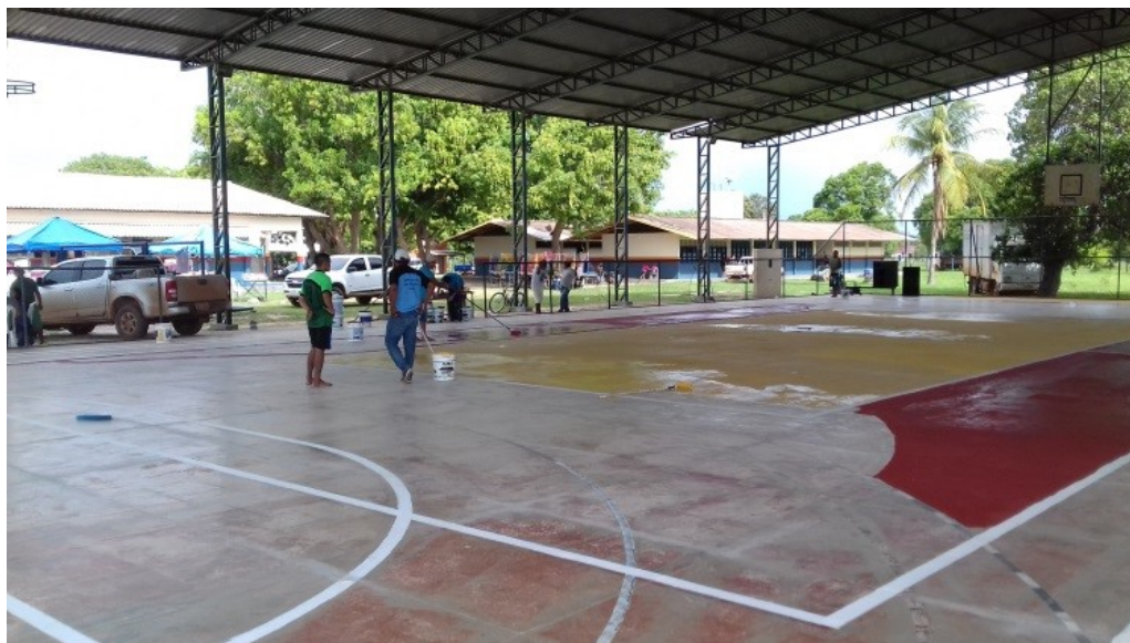
Foto 7 – Quadra Poliesportiva em reforma em maio de 2018, ao fundo os dois prédios da Escola Estadual Índio Macuxi.
