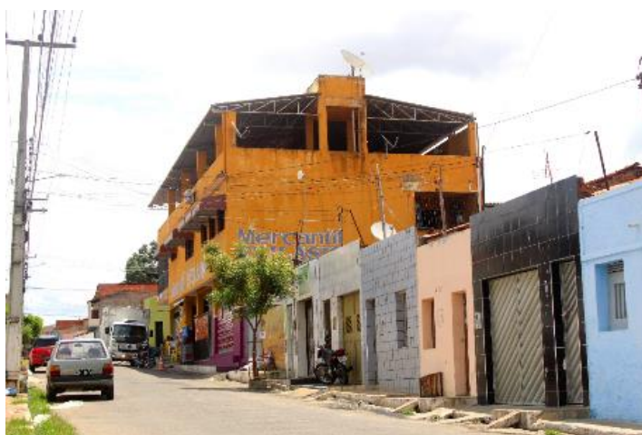
Fotografia 25 - Obstrução na calçada
