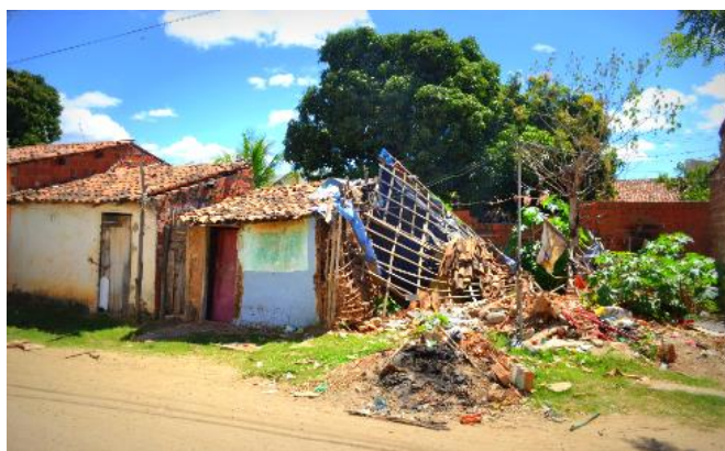
Fotografia 32 - Moradia Precária no bairro Triângulo
