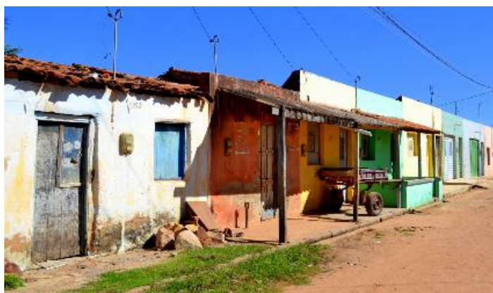
Fotografia 34 - Moradias no bairro Pedrinhas
