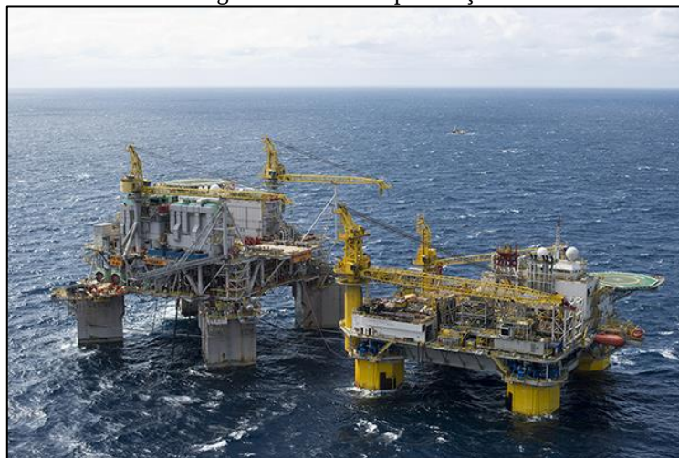
Figura 6 - Sonda de perfuração
