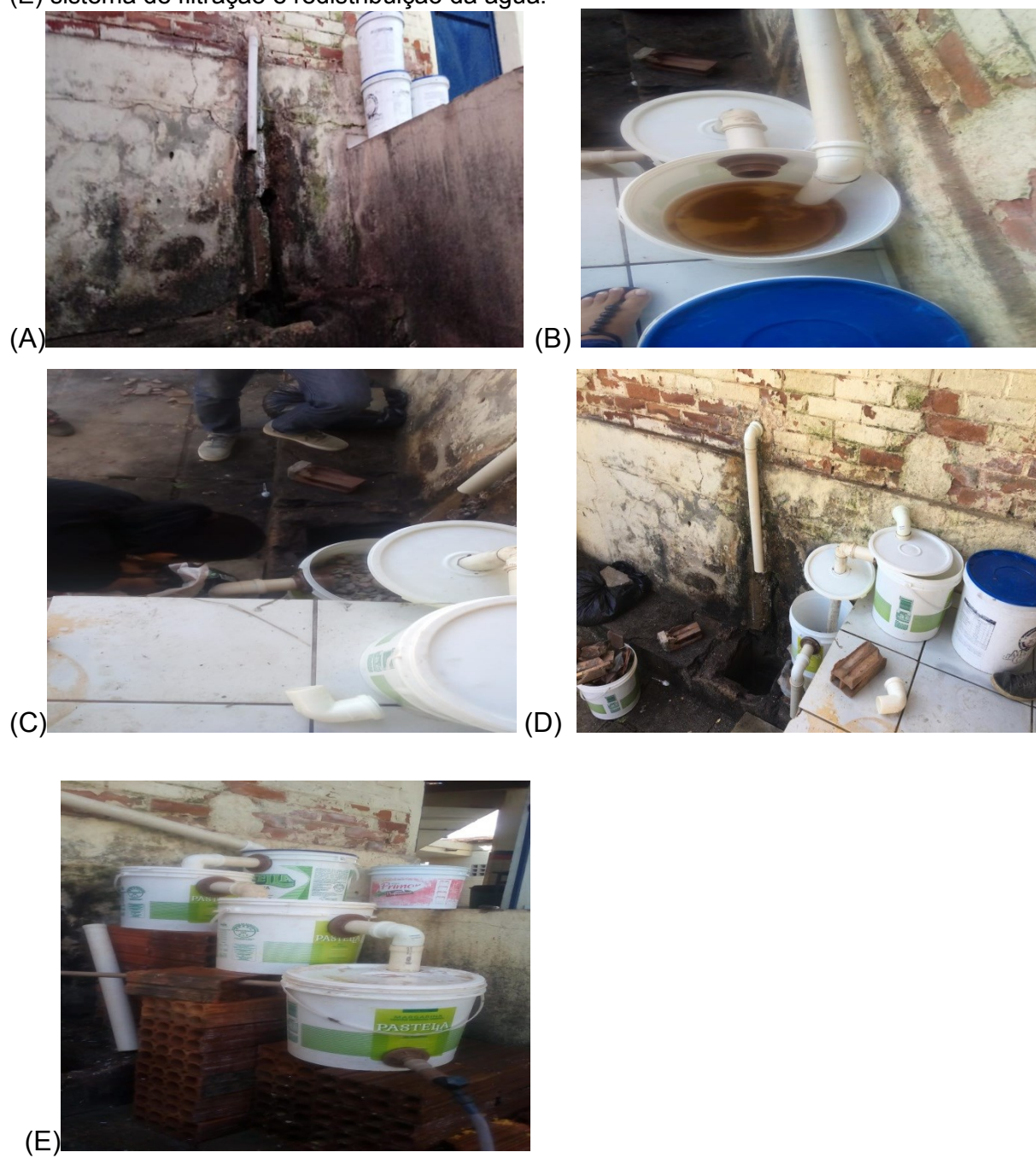
Figura 5: Água cinza da pia da cozinha: (A) antes do projeto; (B a D) construção do sistema; (E) sistema de filtração e redistribuição da água.
