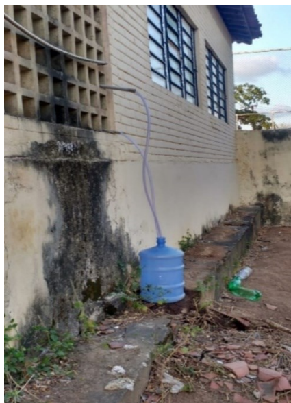
Figura 4: Captação de água: (A) de descarte dos bebedouros; (B) do ralo e pia próxima à cozinha.
