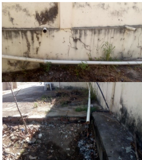
Figura 4: Captação de água: (A) de descarte dos bebedouros; (B) do ralo e pia próxima à cozinha.
