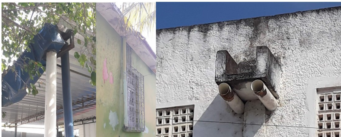
Figura 18: Calhas de água encontradas em área urbana.
