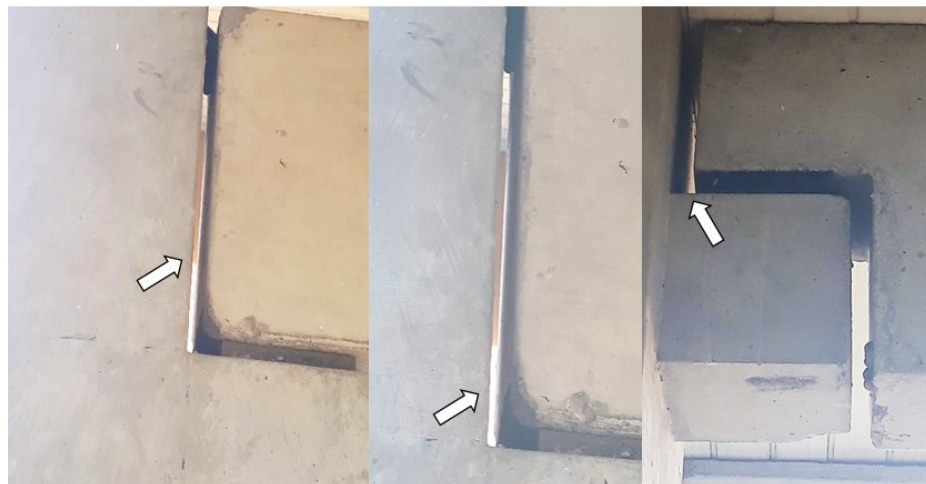
Figura 16: Espaçamento entre paredes em prédio.
