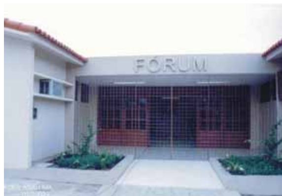
Figura 4.11f. Foto entrada principal
