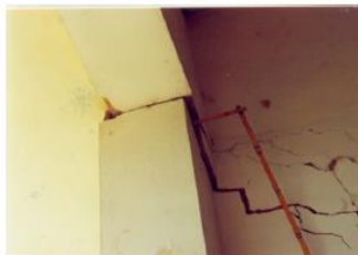
Figura 10 - Possíveis danos causados em edificações devido ao colapso do solo de fundação.
