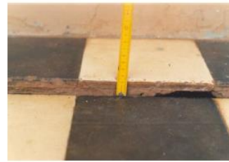
Figura 10 - Possíveis danos causados em edificações devido ao colapso do solo de fundação.
