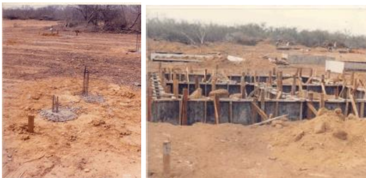
Figura 31 - Fundações executadas na Agrovila 15 do Reassentamento de Itaparica, em Santa Maria da Boa Vista -PE.
