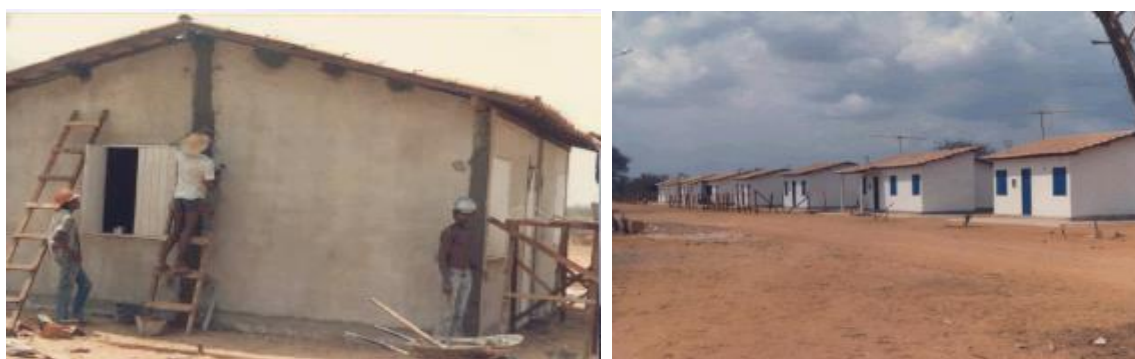
Figura 27 - Casas executadas no Reassentamento de Itaparica em Santa Maria da Boa Vista-PE.
