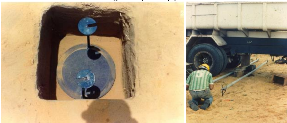
Figura 41 - Placa de carga utilizada nos ensaios em Petrolândia-PE e o sistema de carga com caminhão carregado de paralelepípedos.
