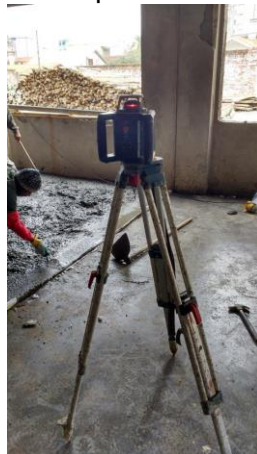
Figura 4 - Nível eletrônico a LASER para demarcações de nivelamento do piso
