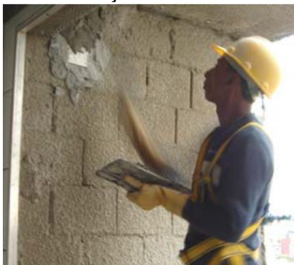
Figura 2 - Execução de taliscas e mestras
