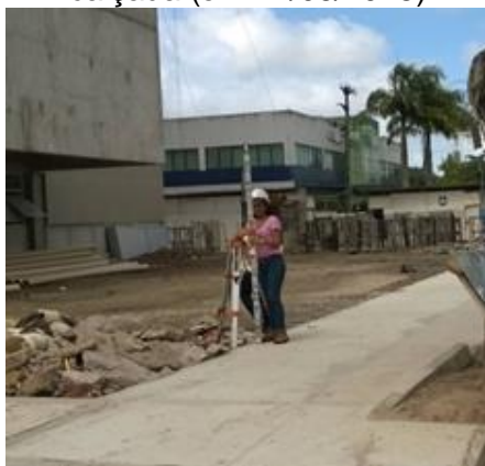
Figura 57 - Irradiação do nivelamento geométrico para a calçada (em 21/06/2018)
