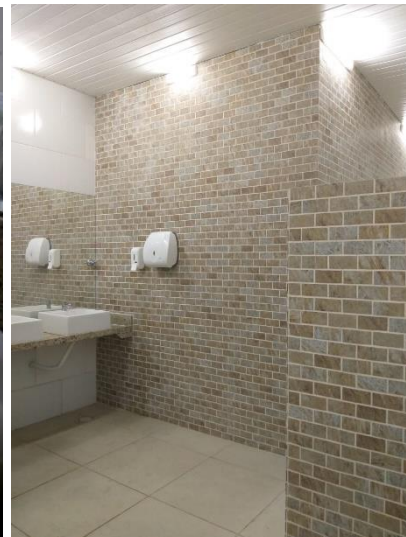
Figura 35 - Banheiro pós reforma
