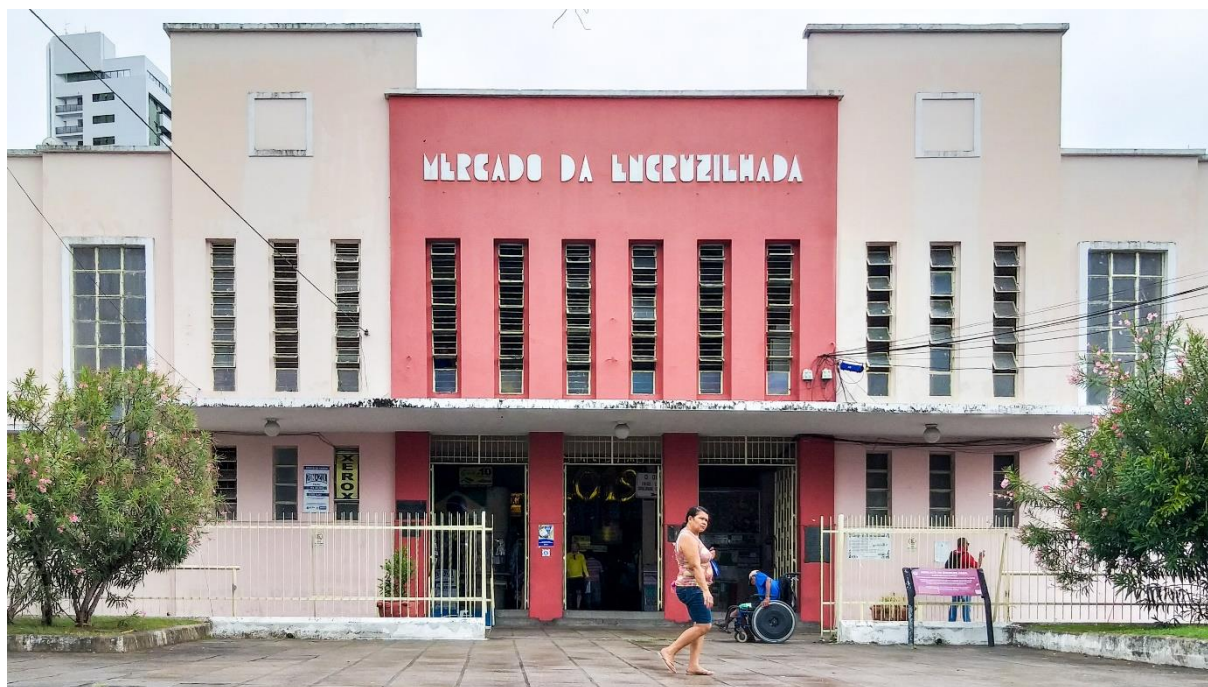
Figura 1 - Fachada principal do Mercado da Encruzilhada
