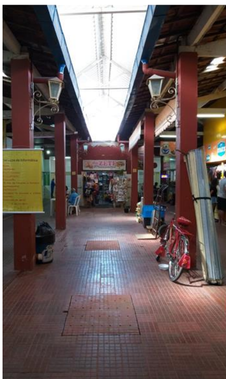
Figura 13 - Estrutura do mercado (pilares)
