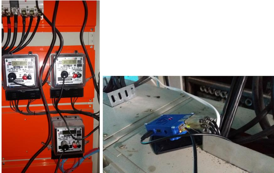
Figura 17 – A) Medidores instalados na sala de força do Dine B) Raspberry PI configurado para o uso do IoTalker, posicionado próximo aos medidores.
