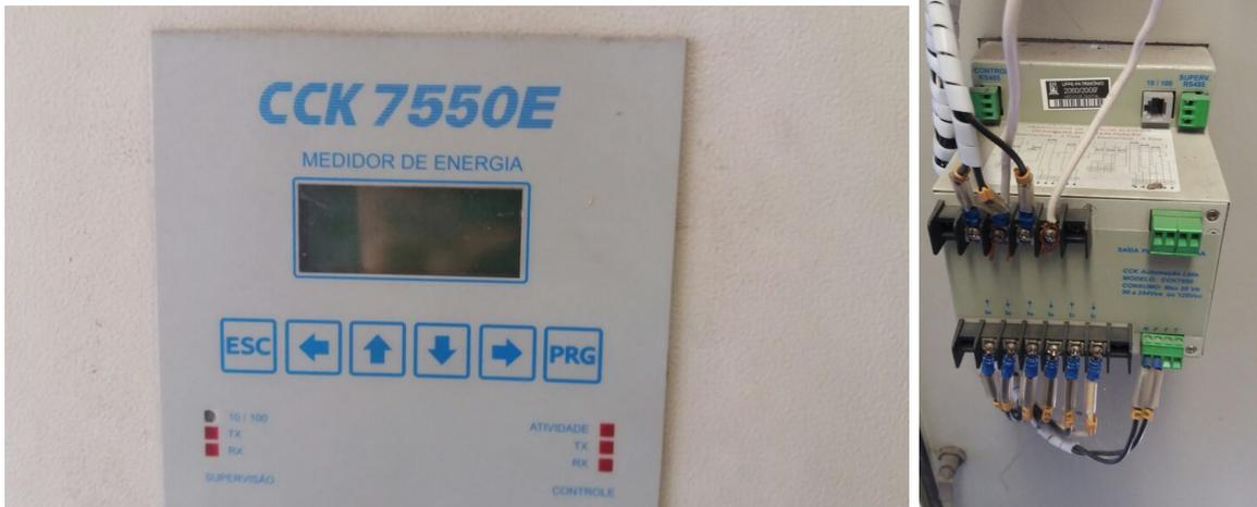
Figura 2 – Medidor 7550E da marca CCK utilizado para o estudo da comunicação *modbus*.
