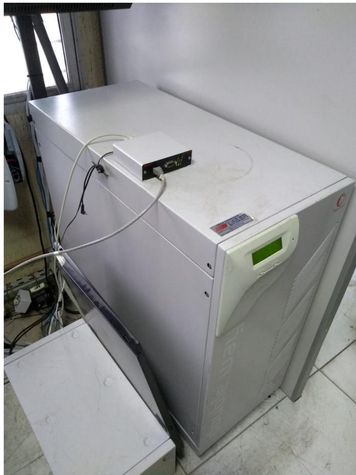
Figura 22 – *Nobreak* instalado no GPRT. As medições são requisitadas via SNMP.
