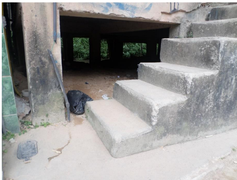
Figura 4 - Casa construída a aproximadamente 1 metro do nível do solo.
