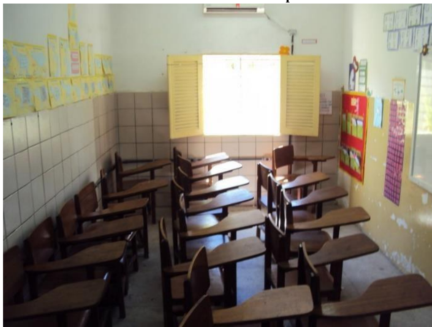
Foto 3 – Sala de aula 02 da Escola Municipal Abílio Gomes
