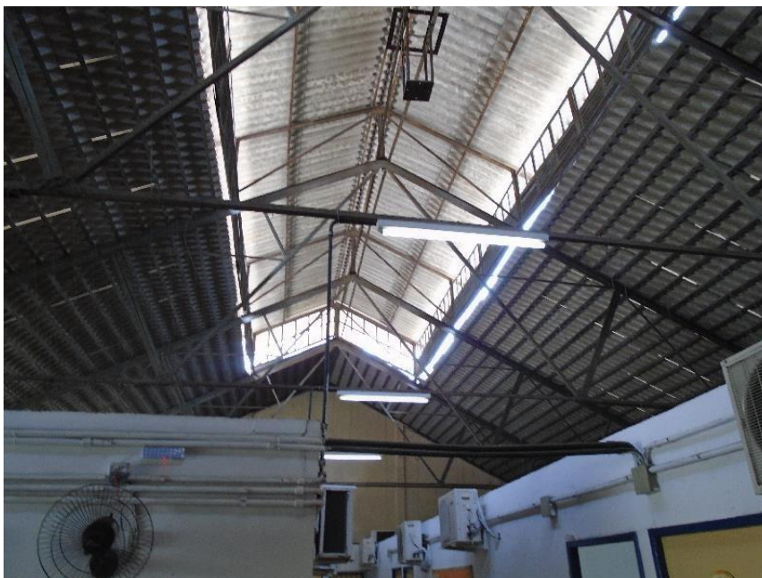
Foto 09 – Telhado da Escola Municipal Diácono Abel Gueiros
