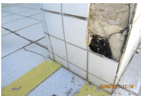
Figura 11 - (a) manta asfáltica aparente (b) fissura em rodapé
