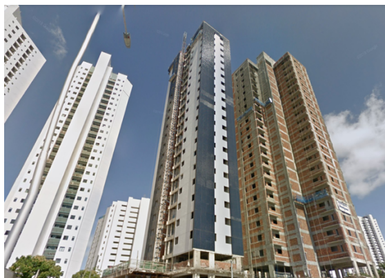
Figura 6 – Edificação de concreto armado em Recife
