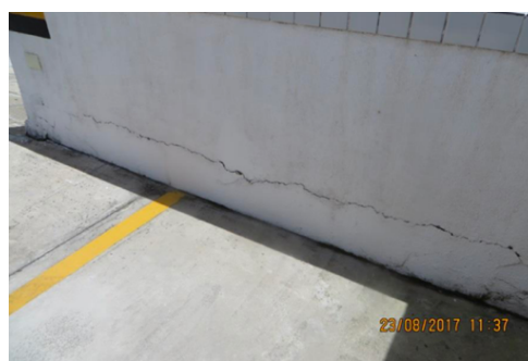
Figura 11 - (a) manta asfáltica aparente (b) fissura em rodapé
