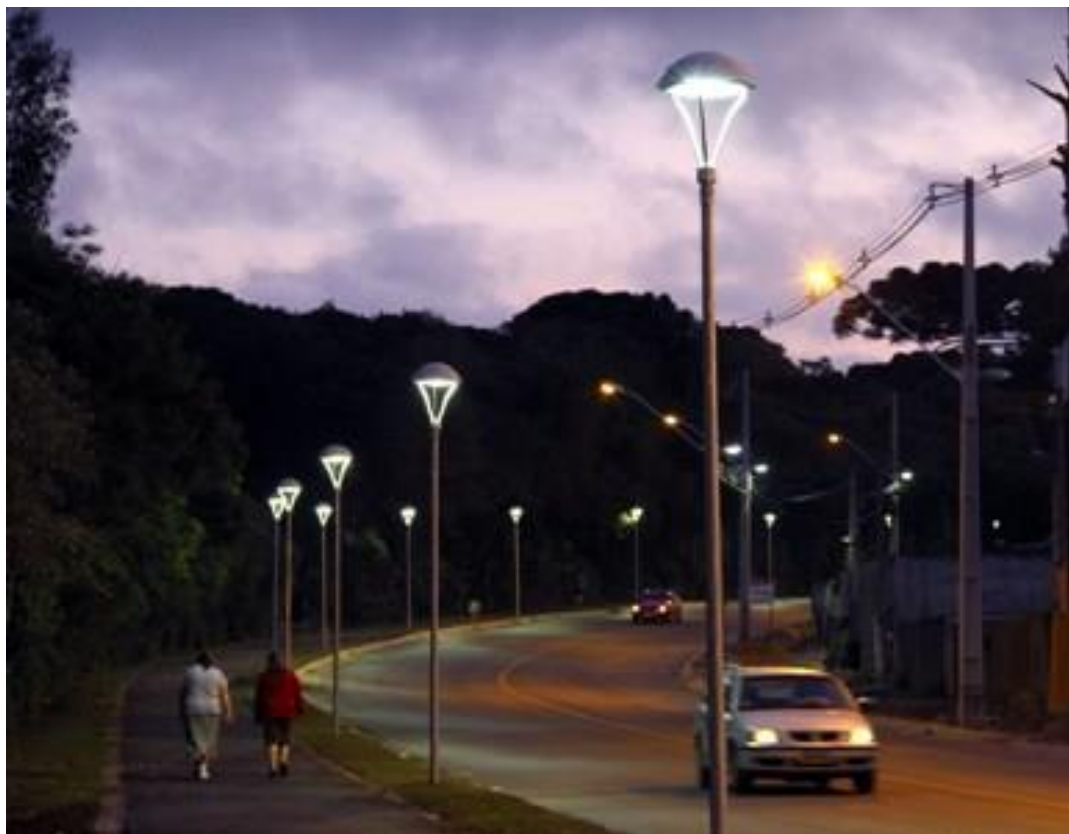
Figura 60: Exemplo de poste de iluminação pública em Curitiba
