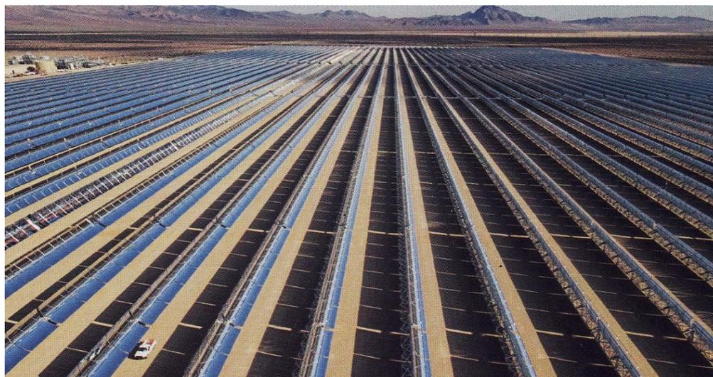
**Figura 2** - Tecnologia de coletores cilíndricos parabólicos - Nevada Solar One – 64 MW –
