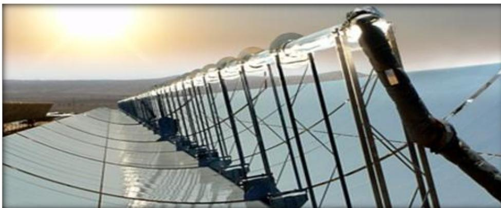
**Figura 1** - Detalhe de um concentrador heliotérmico cilindro-parabólico
