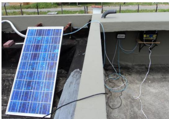
**Figura 48** – Painel Fotovoltaico, controlador de carga e bateria
