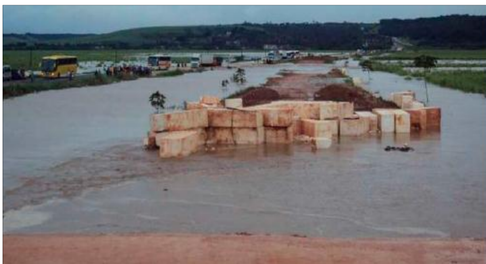
Figura 15 - Flutuação dos blocos de EPS do Aterro 2
