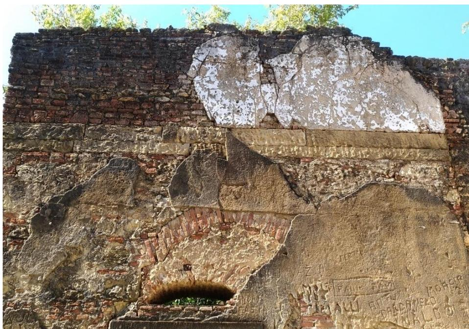
Legenda: A parede 13 B é construída em alvenaria de tijolo e a partir da associação dos tipos de tijolo, rocha e paginação para identificar os tipos de alvenaria existente nas edificações, passou a ser chamada de alvenaria 07. Fonte: Freitas, 2018.
