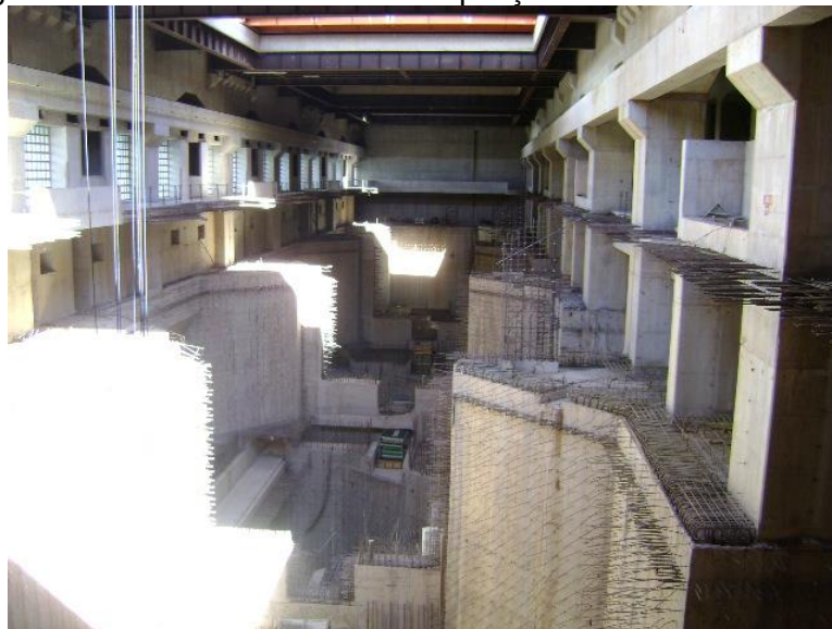
Figura 89 - Estrutura interna da ampliação da UHE Luiz Gonzaga
