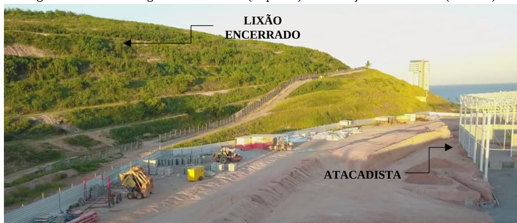
Figura 3 - Vista do antigo lixão encerrado (esquerda) e construção do atacadista (à direita).
