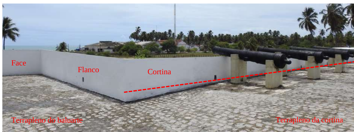
Figura 259 – Ilustração do desnível do terrapleno para que os canhões da cortina sudeste pudessem disparar à barba no Forte de Santo Inácio de Loyola. Fonte: Elaborada pelo autor.
