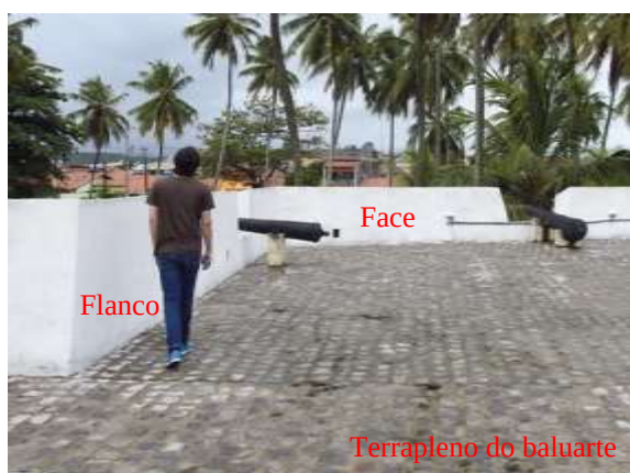
Figura 257 – Parapeito com canhoneiras no baluarte norte do Forte de Santo Inácio de Loyola. Fonte: Elaborada pelo autor.
