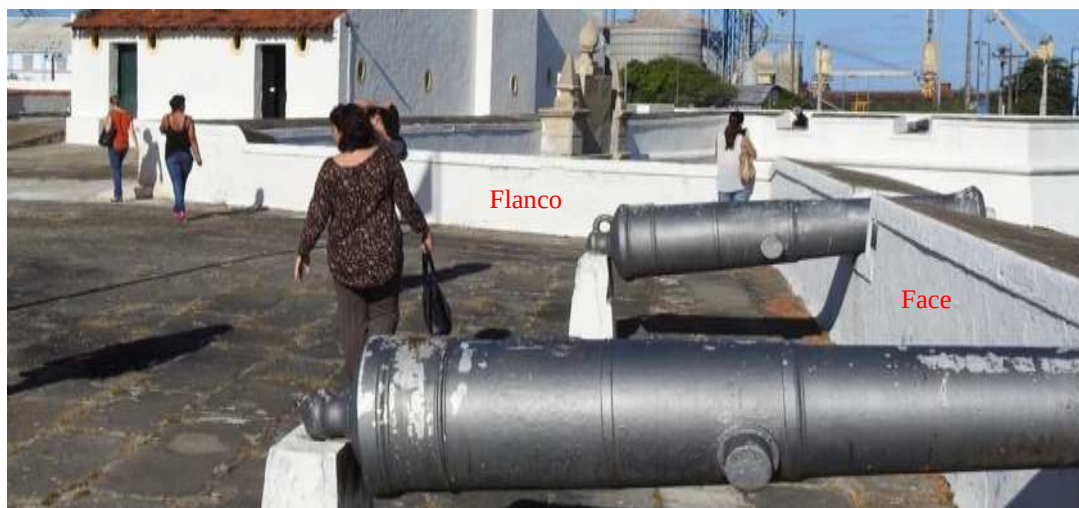
Figura 187 – Trecho do baluarte A. À direita, face com canhoneiras. À frente, flanco sem canhoneiras, mas com parapeito mais baixo, provavelmente para tiros à barba.
