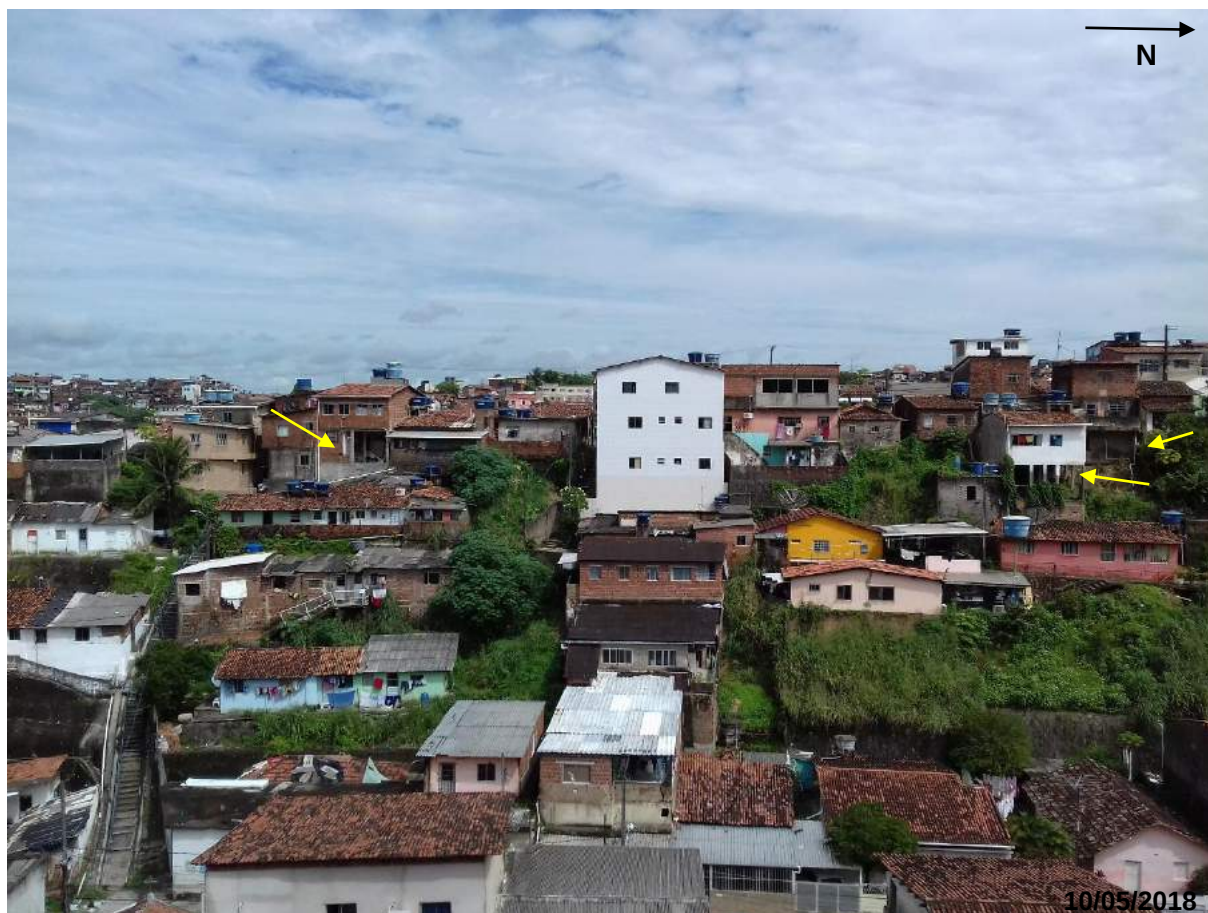
Foto 8 - Vista do Alto José Bonifácio, Regional Noroeste. Nos detalhes (setas amarelas) vê-se construções sobre pilotis, causa de maior instabilidade nas construções.
