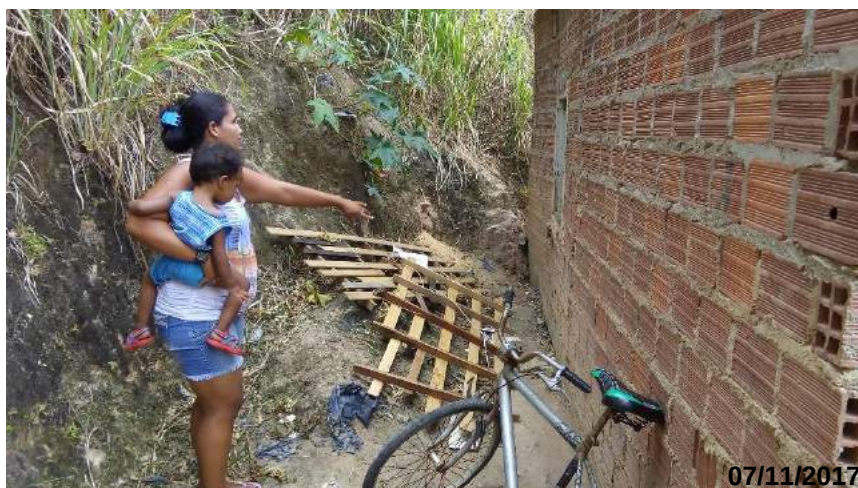
Foto 6 - Córrego do Carroceiro, 8ª Subida, Regional Nordeste. Coordenadas 287313/9117154UTM. Construção realizada no pé do talude, ponto de risco alto quando for época de chuvas.
