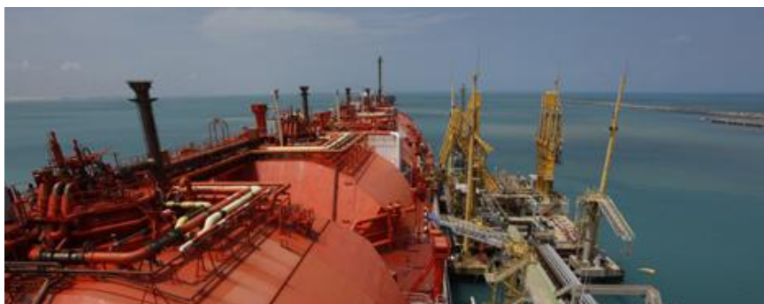
Figura 5 - Terminal de Regaseificação de Pecém (GNL)
