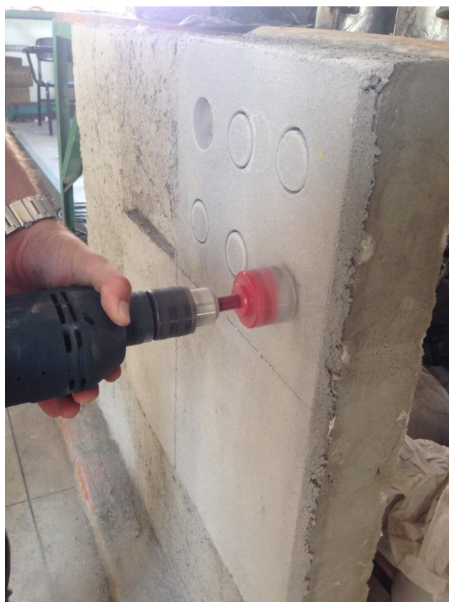
Figura 16 – Preparação da parede com argamassa para o ensaio de aderência à tração.
