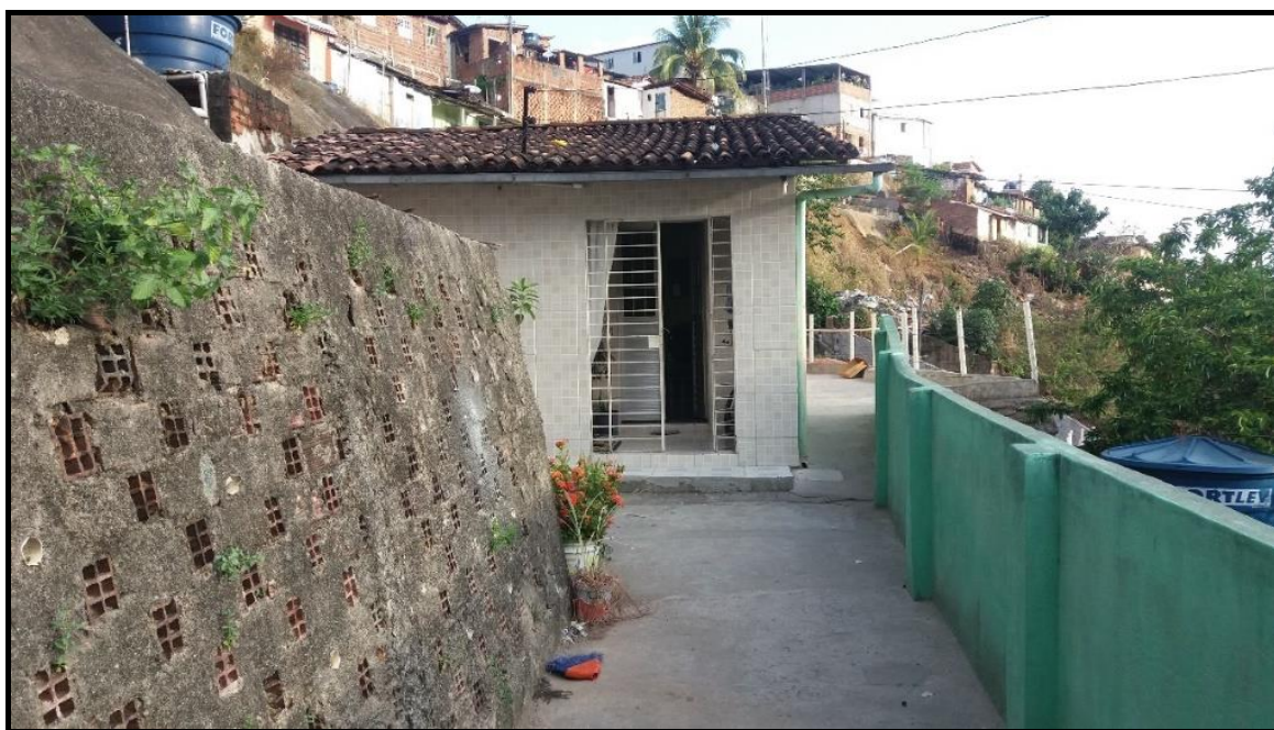
Figura 36 – Frente da casa de dona Dália e muro de contenção de barreira
