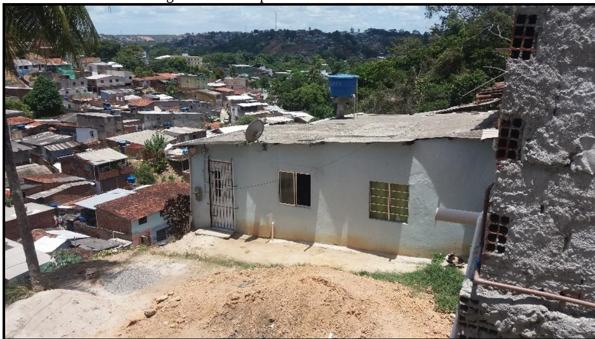
Figura 30 – Casa próximo ao local onde ocorreu desastre
