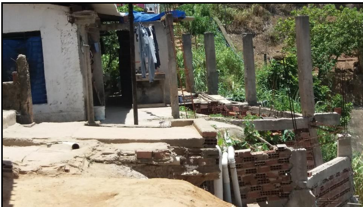
Figura 32 – Obra paralisada, continuação da travessa da rua Alterosa
