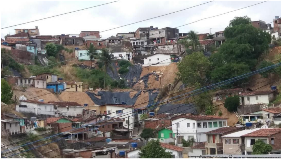
Figura 6-Região do Alto da Saudade (vista da escararia da Rua Nestor Tavares, acesso pela Rua Córrego José Grande)
