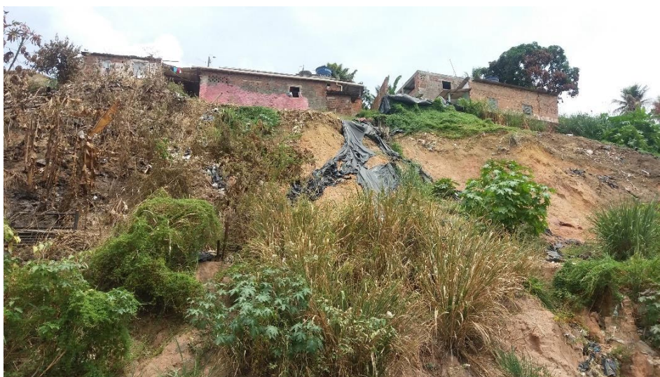
Figura 42 – Casa de dona Edelvais no Boqueirão, vista do Córrego do Euclides
