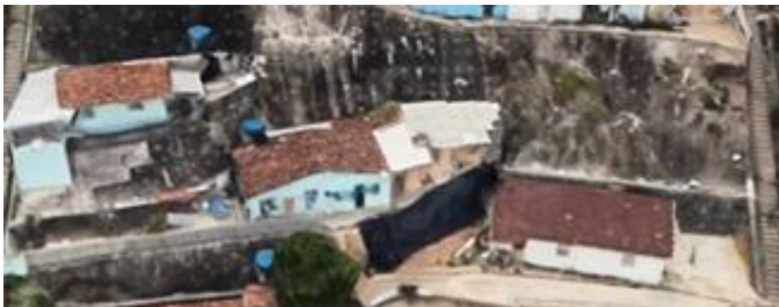
Figura 38- Imagem da escada da rua Tejipió e das obras de contenção da casa de Dália e entorno
