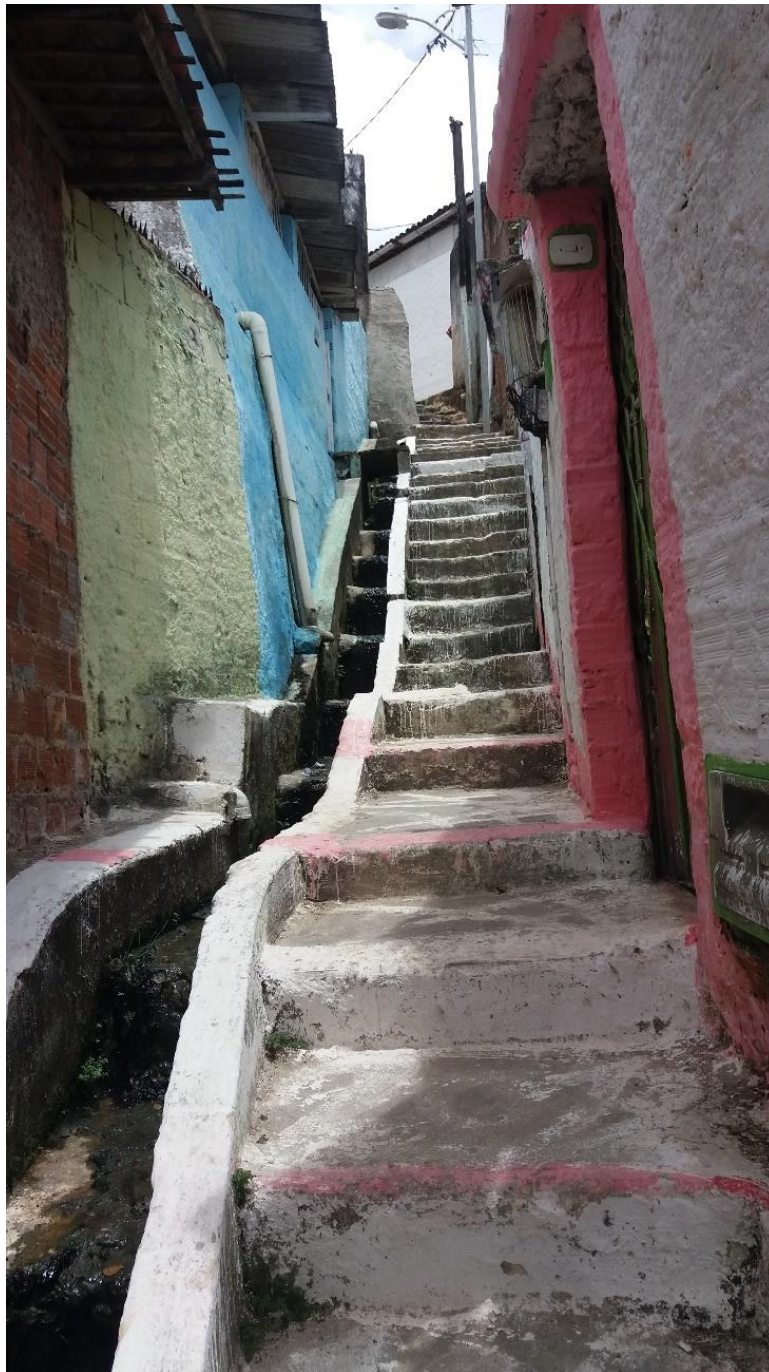
Figura 7 – Escadaria da rua Amoreira, região do Alto do Brasil
