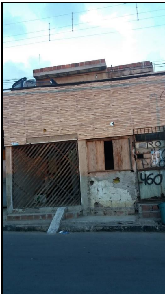
Figura 41 – Casa construída em uma das ruas principais do bairro, no Alto da Saudade
