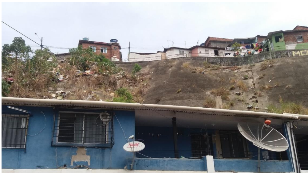
Figura 5- Casas sobre muro de contenção na área do Boqueirão, região do Alto José Bonifácio (vista da rua do córrego do Euclides)
