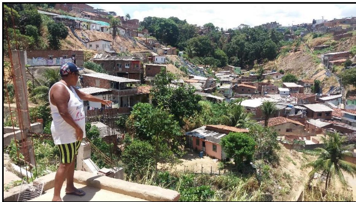
Figura 31 – Moradora sobre obra paralisada na Travessa da rua Alterosa
