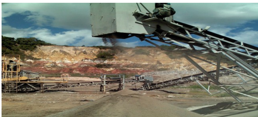
Figura 11- Usina de Reciclagem de RCD
