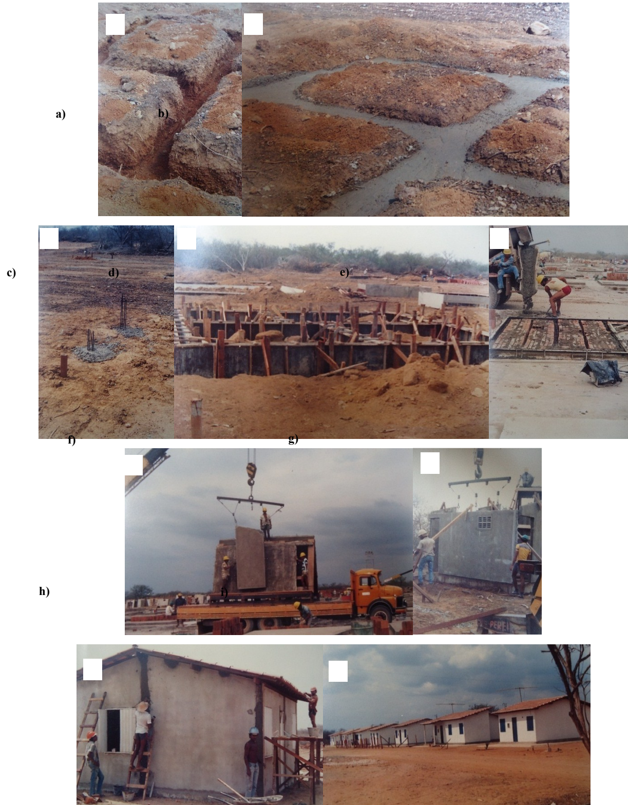
Figura 27- a) a escavação das valas; b) a concretagem das sapatas corridas (solução em fundações superficiais); c) a execução das estacas moldadas in loco (solução em estacas); d) a montagem das formas das vigas de cintamento (solução em estacas); e) fabricação dos painéis de alvenaria armada; f) transporte dos painéis; g) montagem de uma casa; h) ajustes e acabamentos de uma casa; i) casas concluídas.
