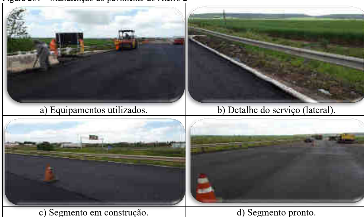
Figura 201 – Manutenção do pavimento do Aterro 2
