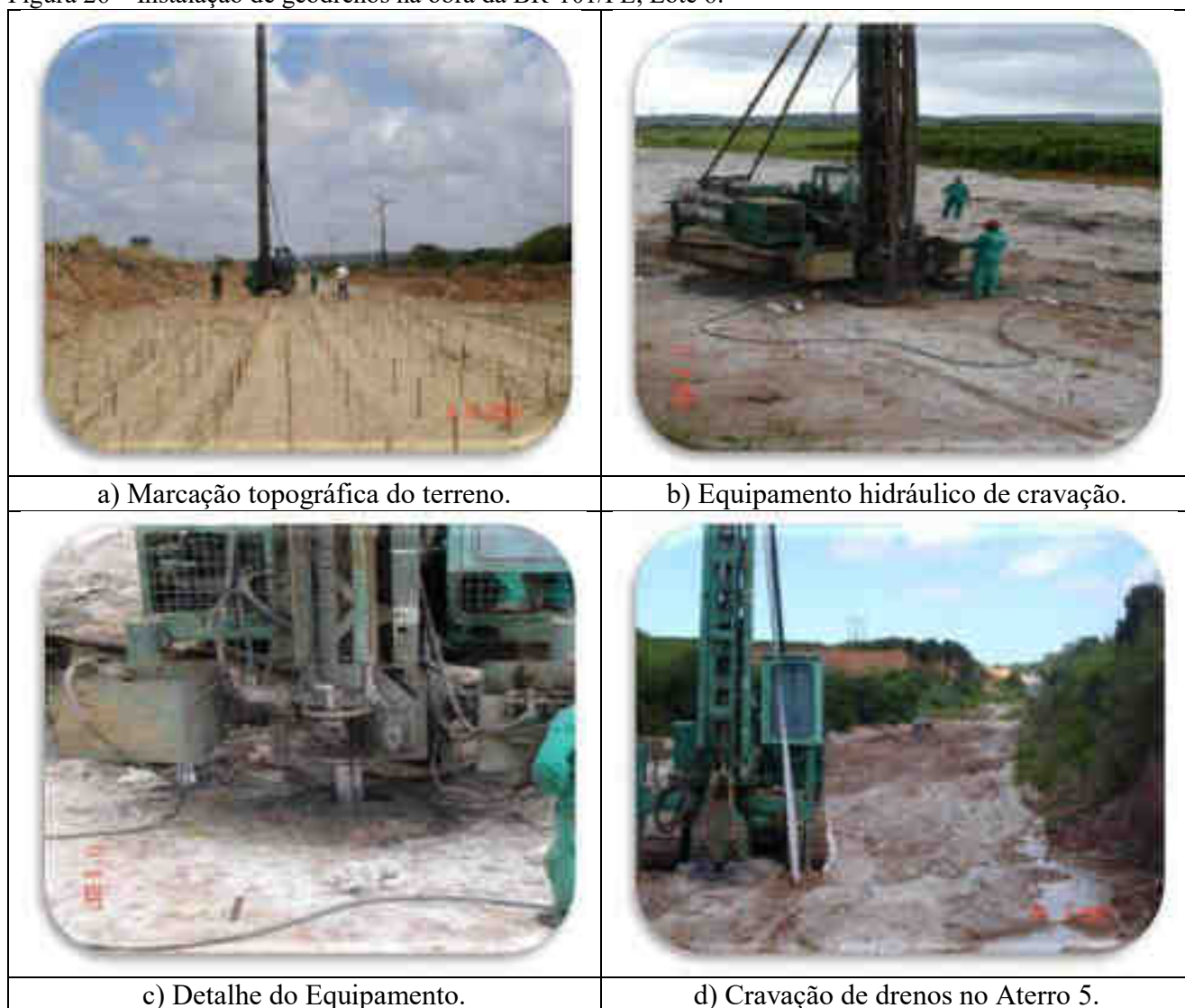
Figura 26 – Instalação de geodrenos na obra da BR-101/PE, Lote 6.
