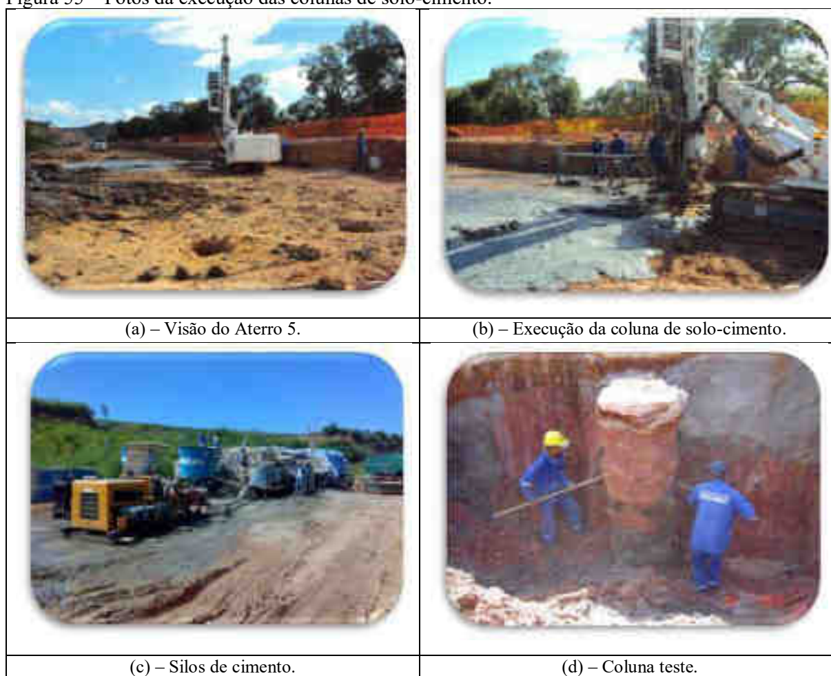
Figura 55 – Fotos da execução das colunas de solo-cimento.
