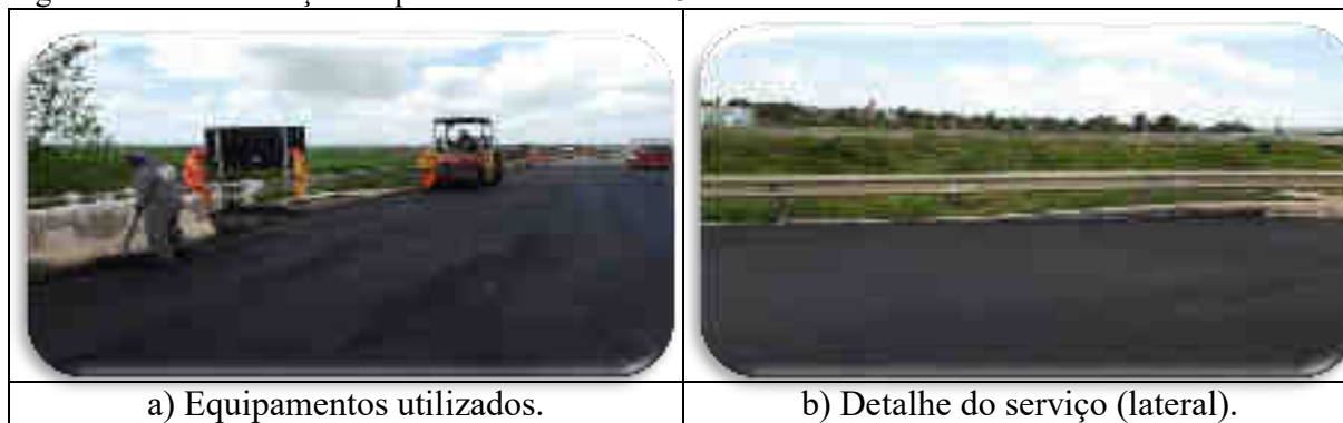
Figura 211 – Manutenção do pavimento do Aterro 3
