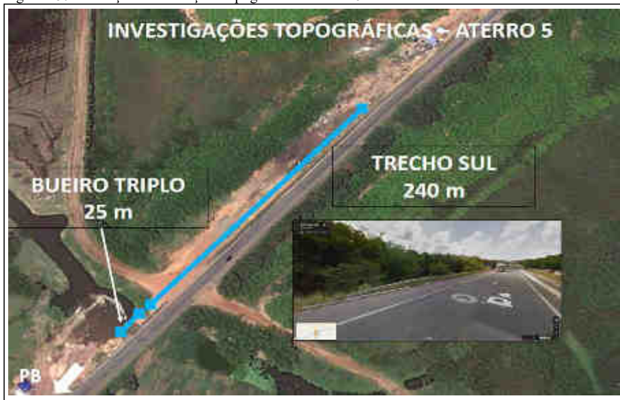
Figura 180 – Localização das medições topográficas – Aterro 5.
