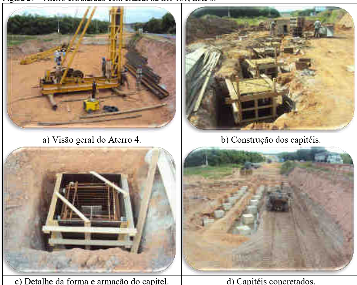
Figura 29 – Aterro estruturado com estacas na BR-101, Lote 6.
