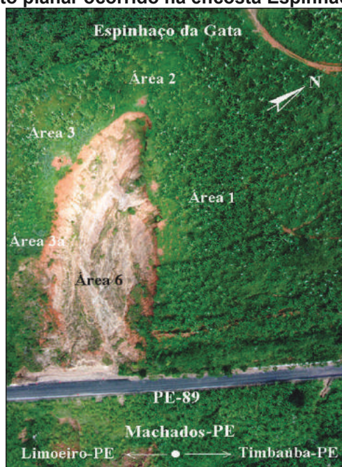
Figura 5 - Deslizamento planar ocorrido na encosta Espinhaço da Gata - PE.
