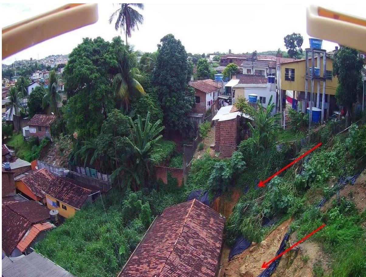
Figura 21 – Movimento de massa em contato direto com edificação, cidade de Camaragibe (PE)
