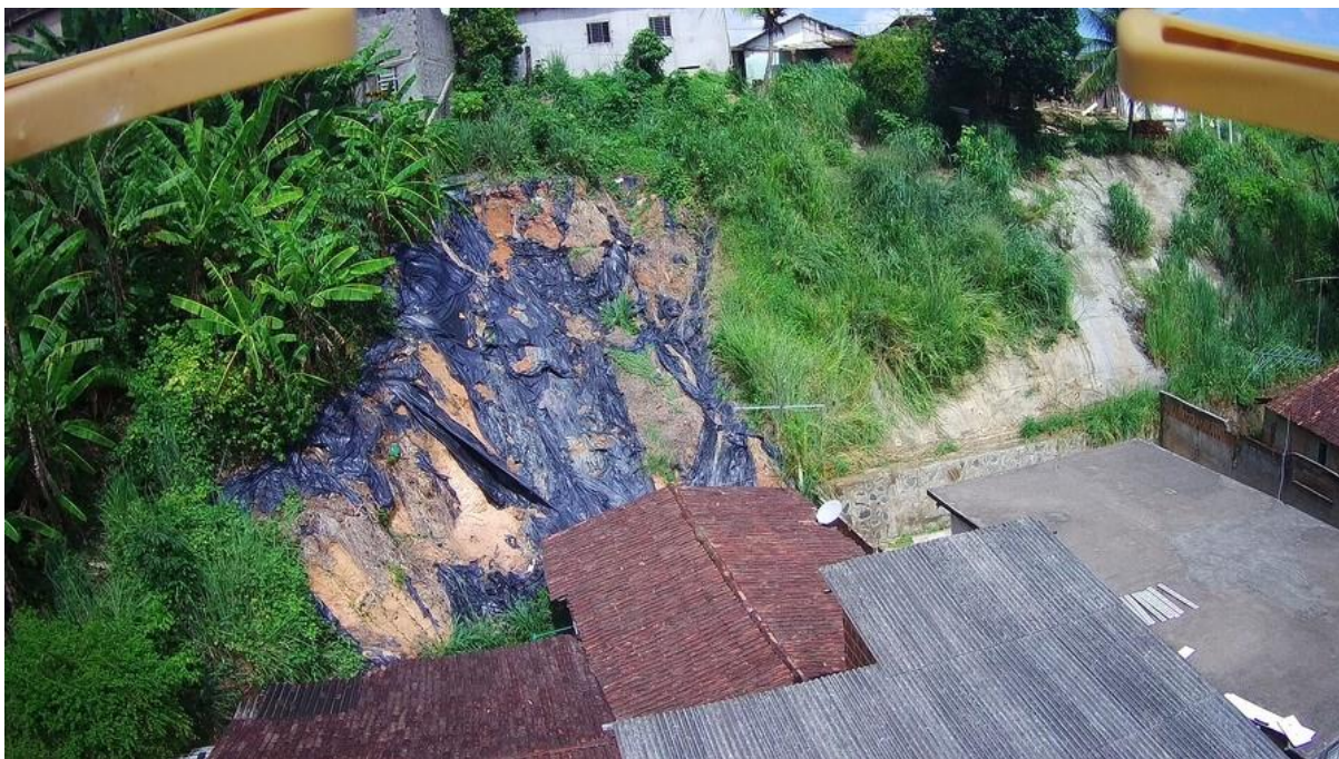
Figura 22 – Desgaste de lonas na encosta RPA IV Tabatinga, cidade de Camaragibe (PE)
