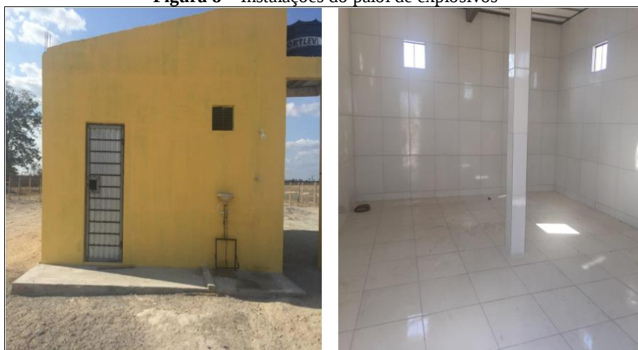
Figura 8 – Instalações do paiol de explosivos
