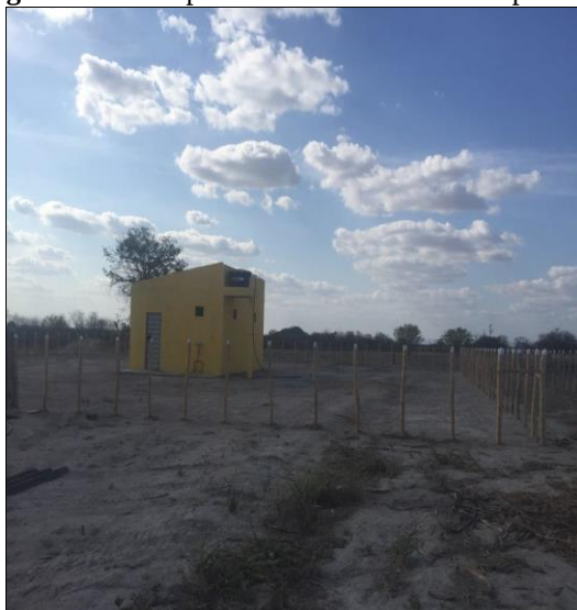
Figura 21: Paiol para armazenamento dos explosivos
