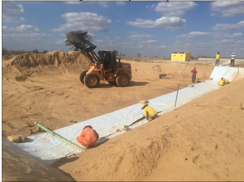
Figura 12: Pilha para lixiviação
