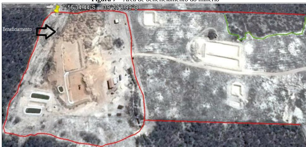
Figura 7 – Área de beneficiamento do minério
