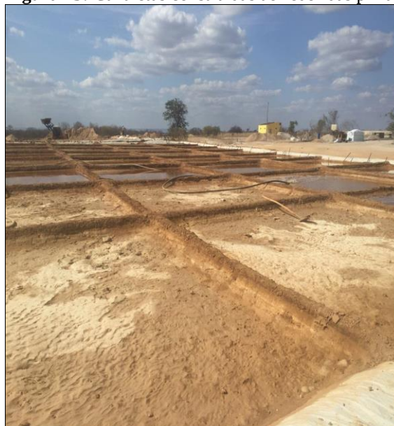
Figura 13: Canaletas construídas ao redor das pilhas
