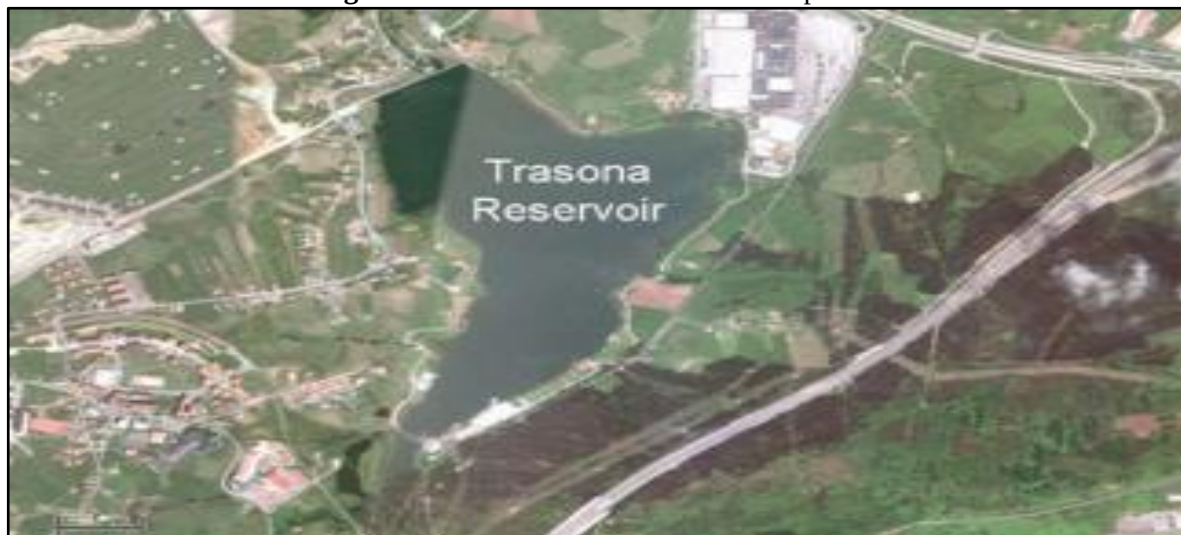
Figura 30 - Reservatório de Trasona - Espanha.
