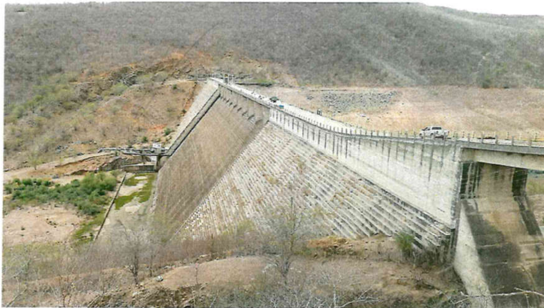
Figura 07 – Vista da Barragem de Jucazinho a jusante
