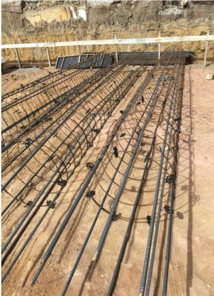
**Figura 115** – Colocação da armação na estaca
