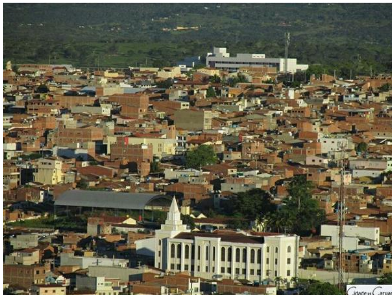
FOTOGRAFIA 7. Vista aérea do bairro Vassoural
