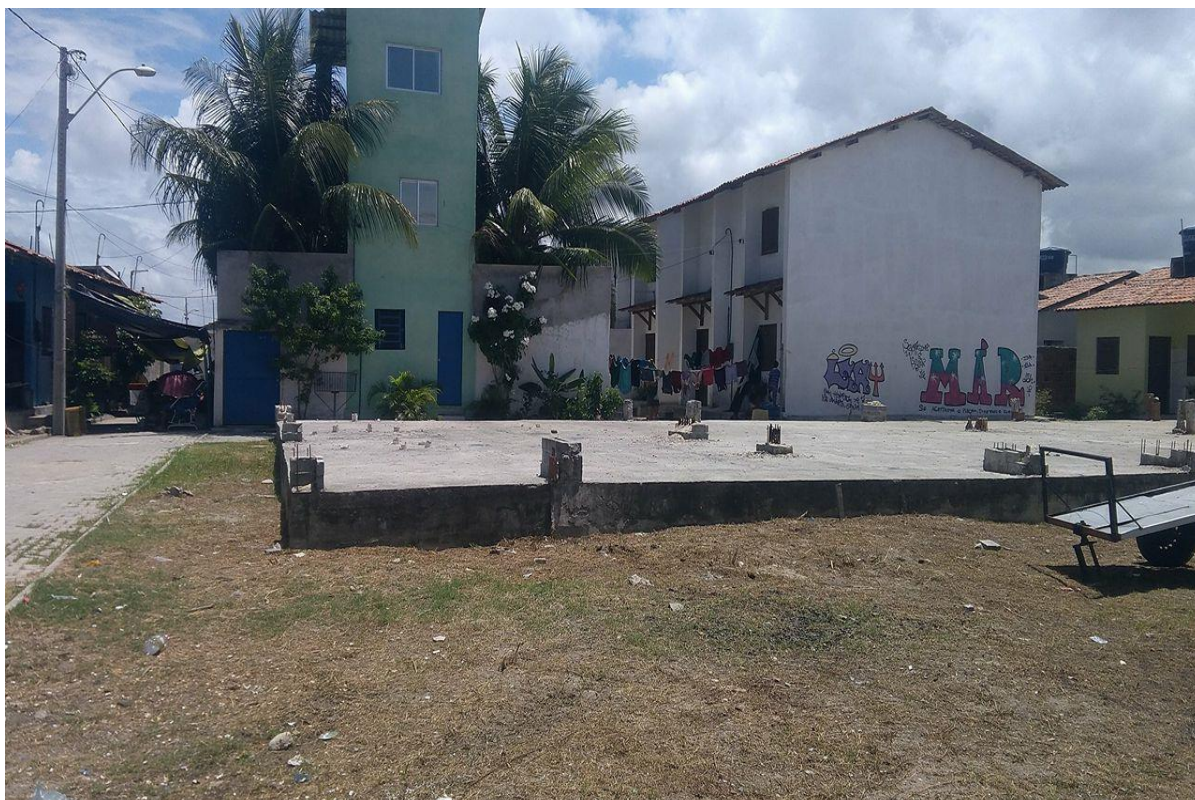
Figura 30 - Espaço para construção da creche
