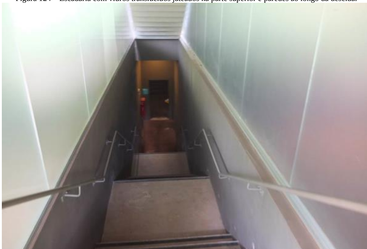
Figura 124 – Escadaria com vidros translúcidos jateados na parte superior e paredes ao longo da descida.
