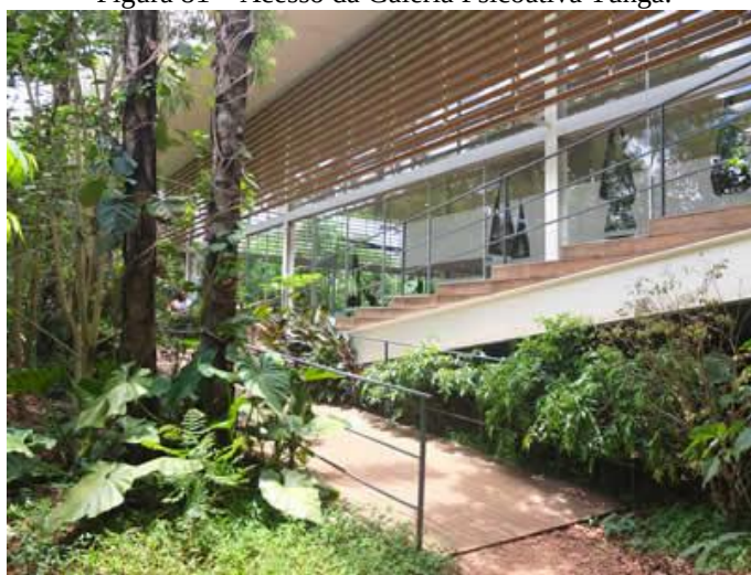
Figura 81 – Acesso da Galeria Psicoativa Tunga.
