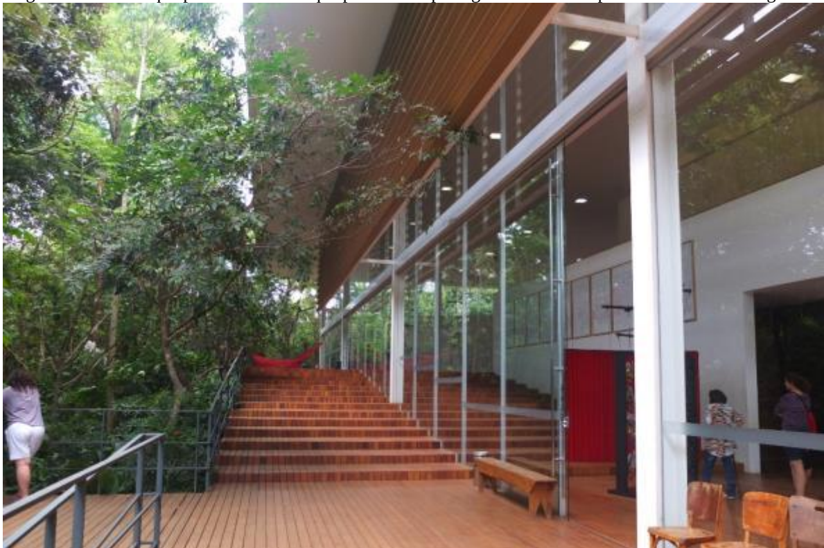
Figura 152 – Destaque para as aberturas que permitem a passagem do visitante para o lado externo da galeria.
