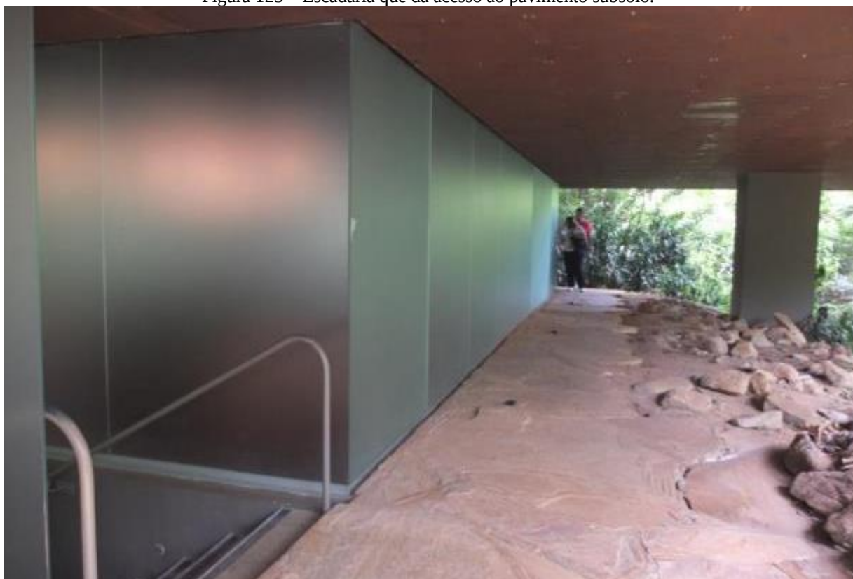
Figura 123 – Escadaria que dá acesso ao pavimento subsolo.
