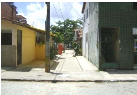
Foto 4.6 – Acesso da Segunda travessa Marechal Bittencourt. Fonte: a autora, 2009.
