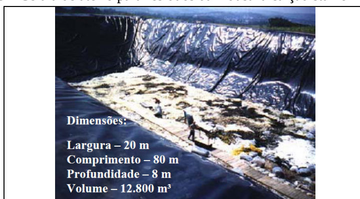
Figura 2.3 – Célula de aterro para resíduos da indústria calçadista no Rio Grande do Sul.
